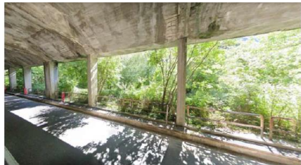
Punto 2 - Vista della galleria lato valle
