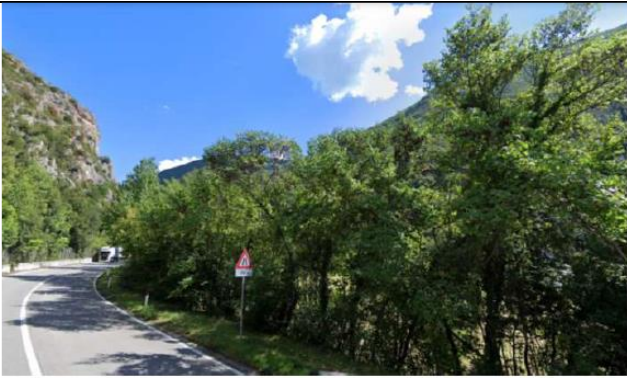
Punto 4 - Vista in direzione di Borgo Cerreto
