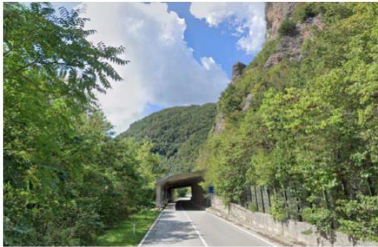
Punto 1 Vista dell'imbocco della galleria in direzione verso Piedipaterno
