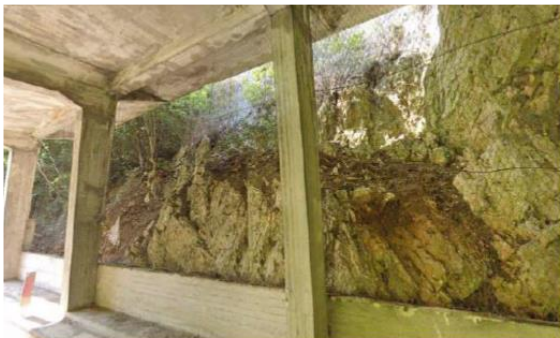
Punto 2 - Vista della galleria lato del versante
