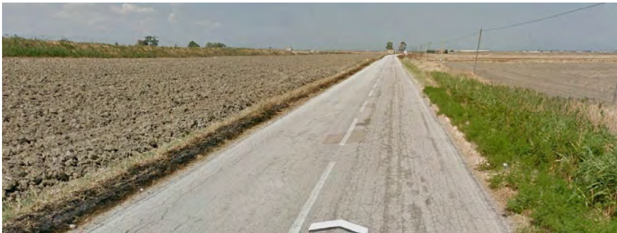
A sinistra l'argine del Canale Cervaro a destra l'area destinata a bosco (compensazione ambientale)
