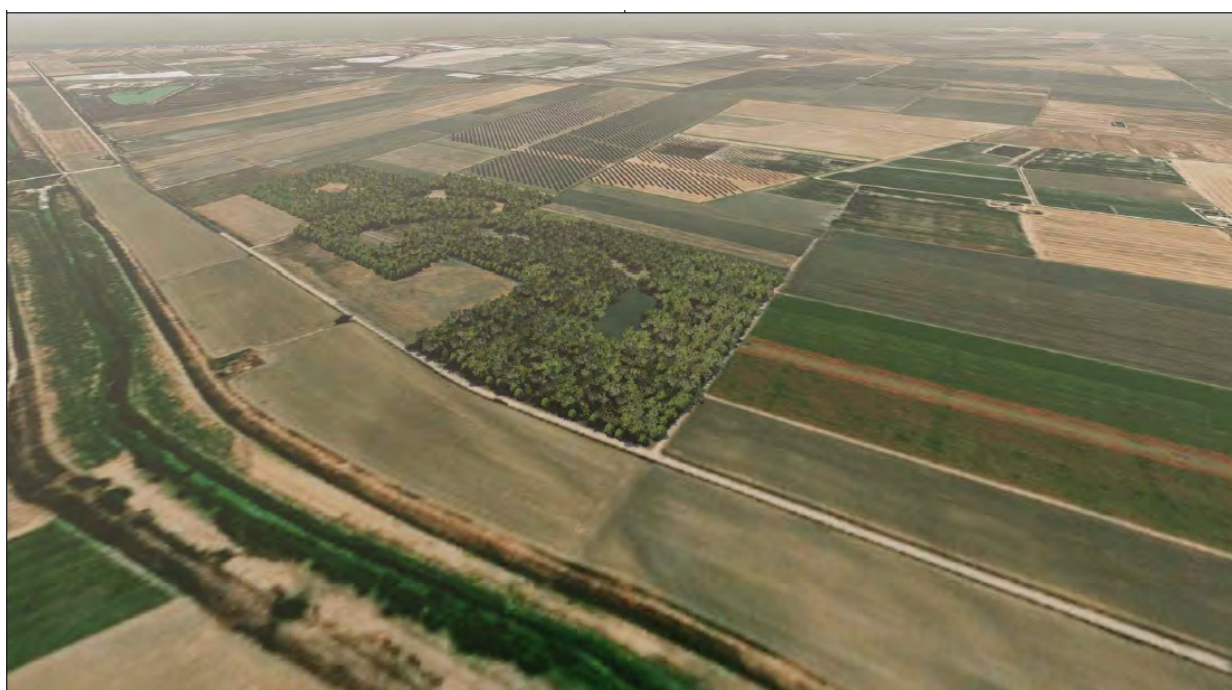
Fig.4 Area di compensazione ed impianto fotovoltaico
