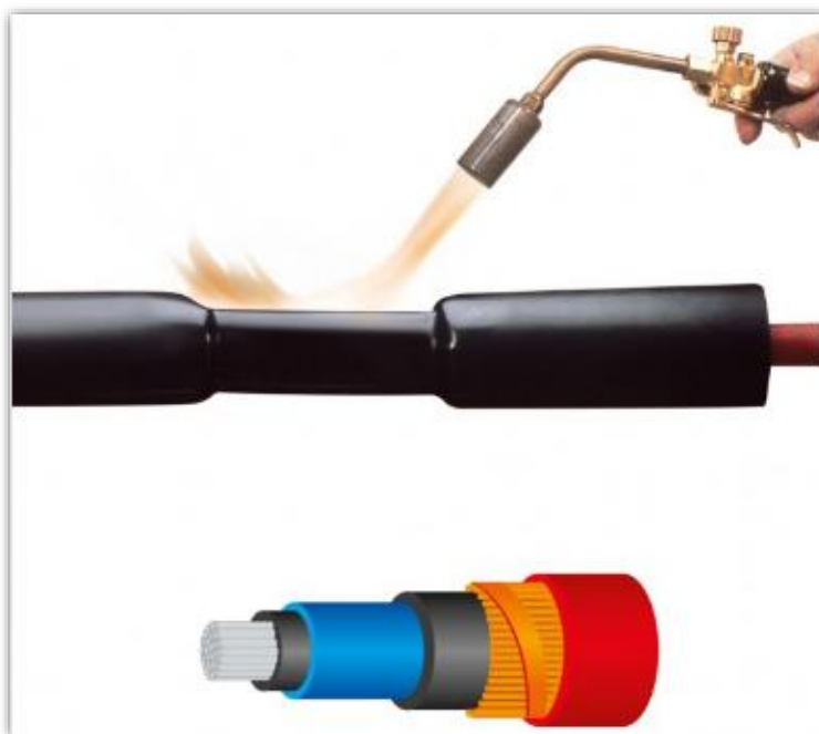
Fig. 15. Schema di esecuzione di un giunto MT
