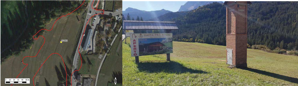
Figura 5.2 - Ubicazione del punto SEZ01 e panoramica.
