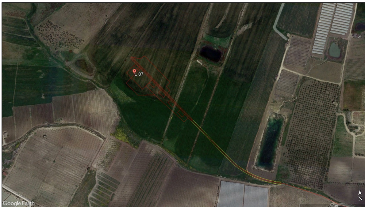
Figura 9. Vista locale dell'area destinata alla WTG n. 7.
