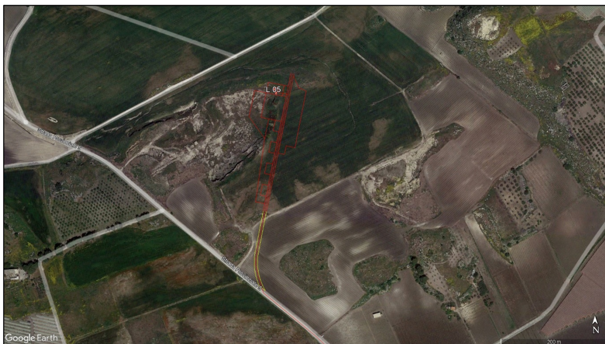
Figura 7. Vista locale dell'area destinata alla WTG n. 5.
