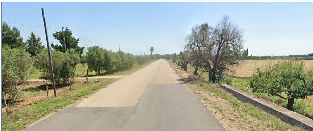
Fig.47 _Strada Provinciale 81, interessata dalla posa dell'elettrodoto di connessione alla rete (tratto intermedio).
