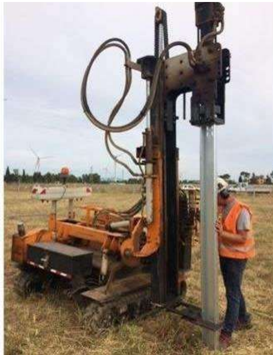
Fig. 77 _ Esempio di supporto costituito da palo in acciaio infisso direttamente nel terreno mediante battipalo
