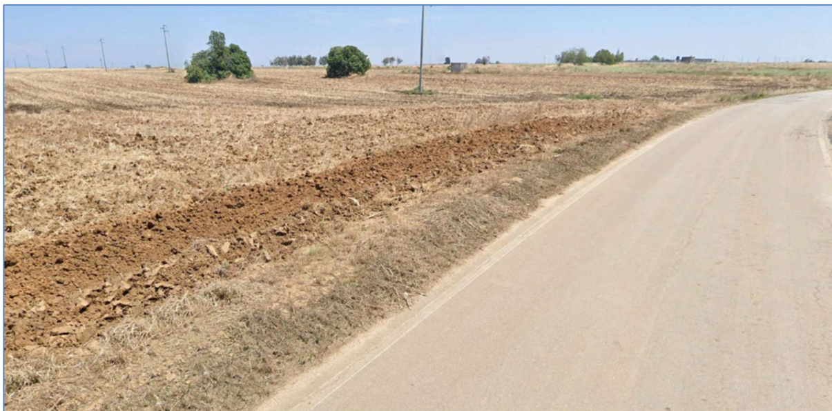
Fig.49 _Strada Provinciale 80, interessata dalla posa dell'elettrodotto di connessione alla rete a raggiungimento della stazione elettrica (tratto finale).
