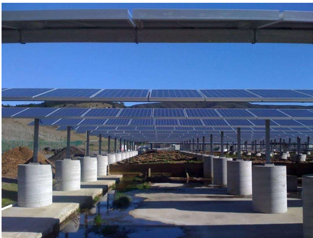
Fig. 79 _ Esempio di impianto fotovoltaico con fondazioni formate da zavorre costituite da plinti in cemento
