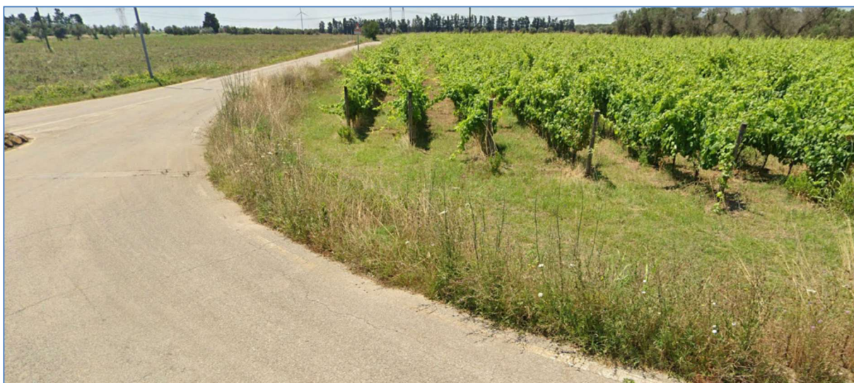
Fig.48 _Incrocio tra la Strada Provinciale 81 e la Strada Provinciale 80, interessata dalla posa dell'elettrodoto di connessione alla rete (tratto intermedio).
