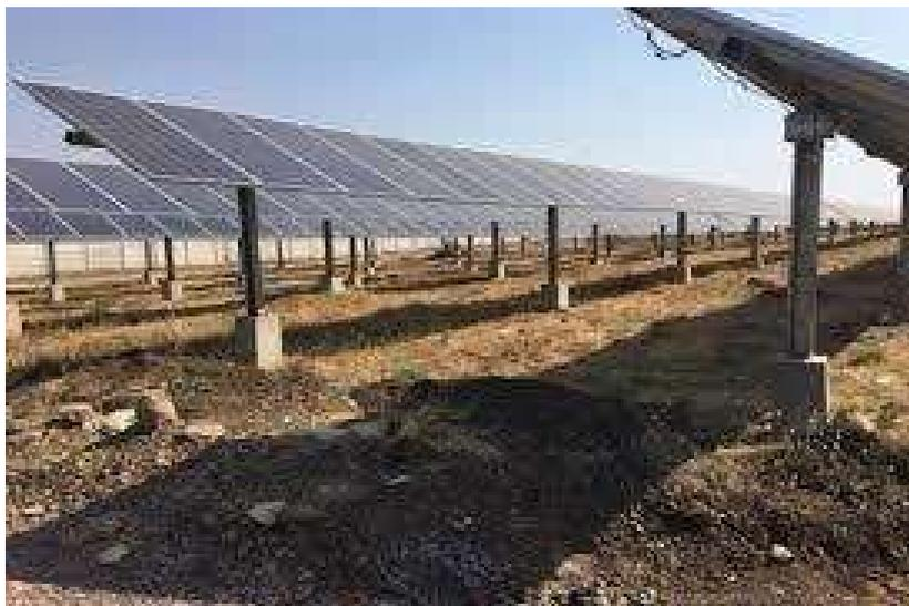
**Fig.43 \_** Esempio di impianto fotovoltaico con fondazioni ottenute mediante perforazione del terreno e
