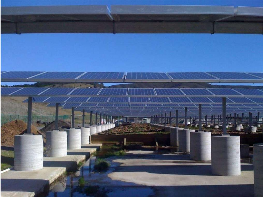
**Fig. 44** Esempio di impianto fotovoltaico con fondazioni formate da zavorre costituite da plinti in cemento
