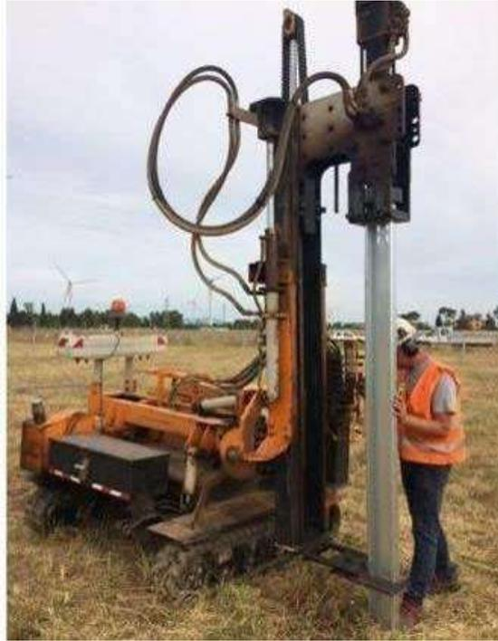
**Fig. 42\_** Esempio di supporto costituito da palo in acciaio infisso direttamente nel terreno mediante battipalo
