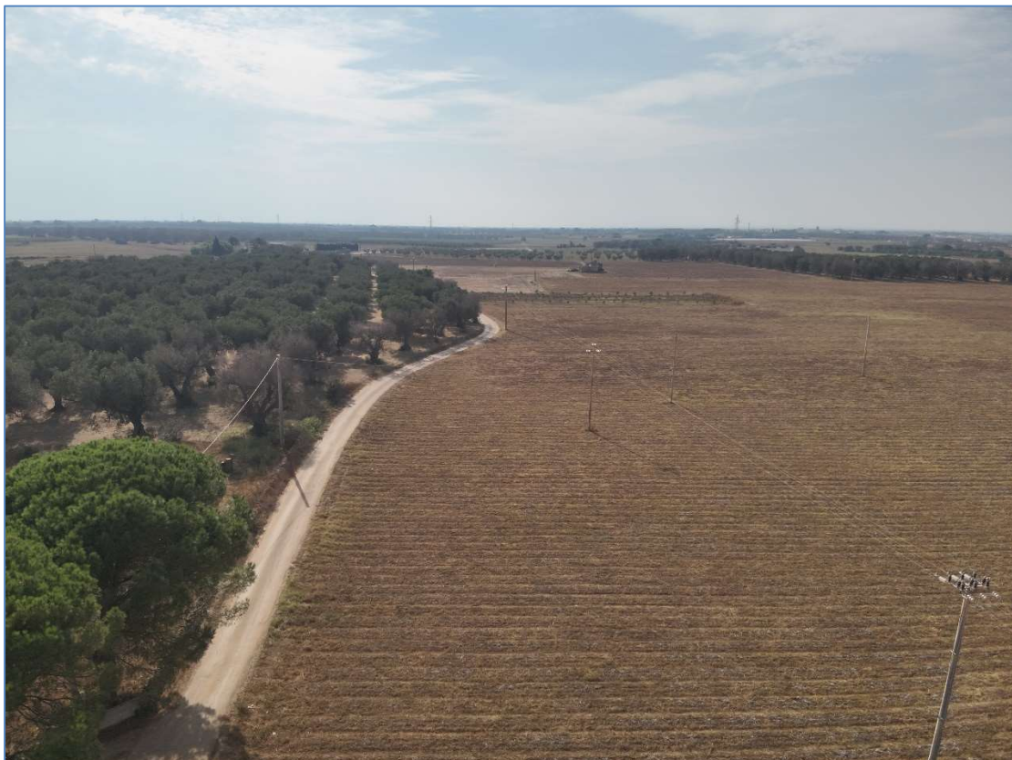
Fig.14_ Foto aerea dell’impianto fotovoltaico
