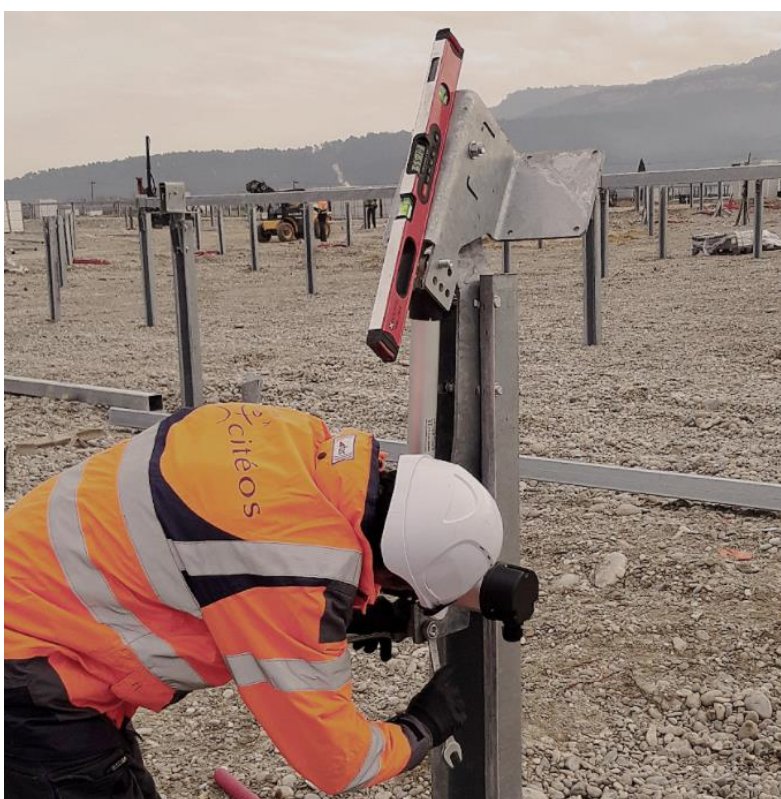
Figura 16 - Montaggio tracker
