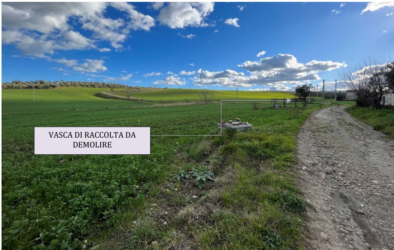
Figura 6: Vasca di raccolta da demolire, vista frontale - PUNTO 3
