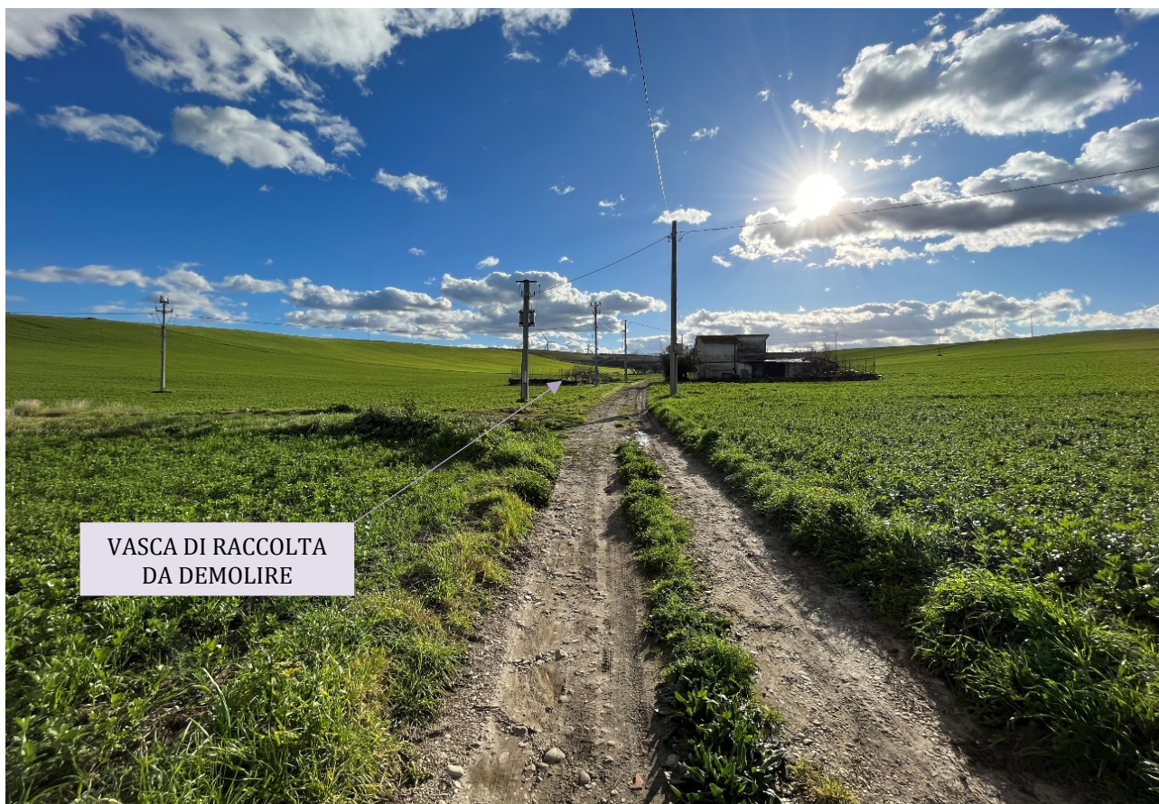
Figura 7: Vasche di raccolta da demolire, vista frontale PUNTO 4
