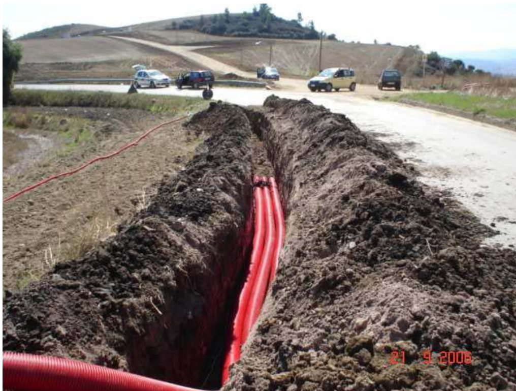
Figura 11: Foto illustrativa della messa in posa dei cavidotti MT
