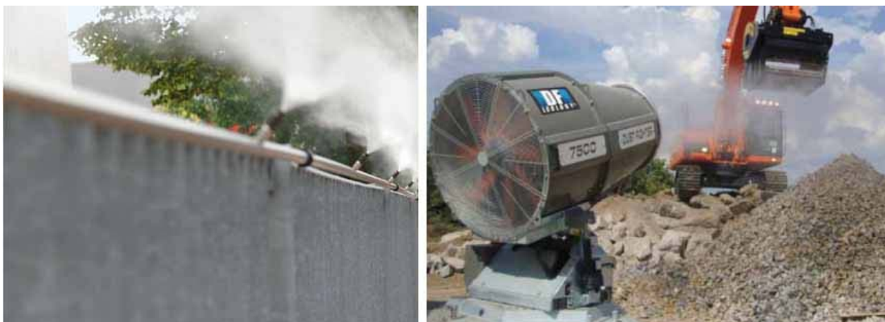
Figura 5: Sistemi di nebulizzazione per l'abbattimento delle polveri
