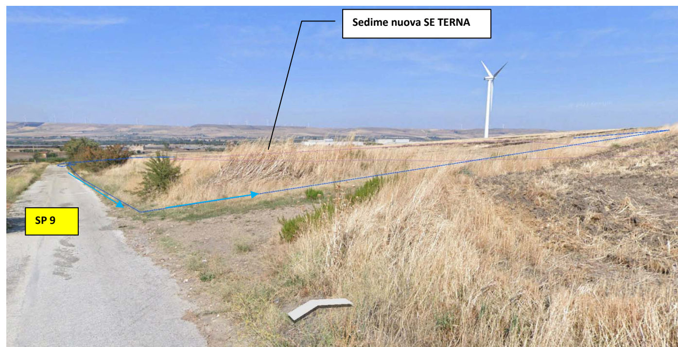
Punto foto "G9": Vista del tracciato del cavidotto AT in arrivo da SP9 a nuova SE TERNA
