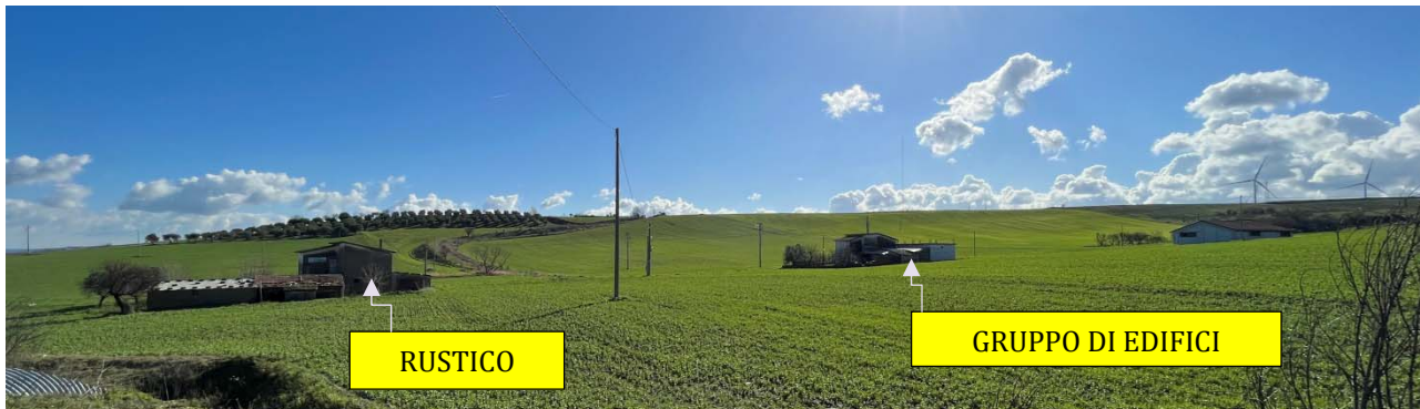
Figura 5: Rustici esistenti a bordo impianto, vista laterale
