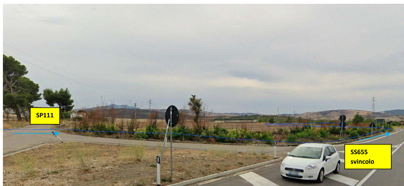
Punto foto "G3": omplanare e svincolo della SS655 vista del tracciato del cavidotto interrato AT
