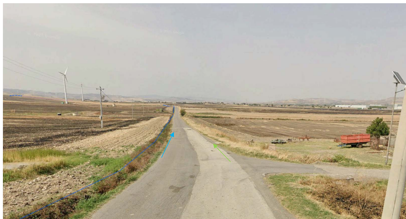
Punto foto "G7": Vista del tracciato del cavidotto AT su strada comunale verso la nuova SE TERNA
