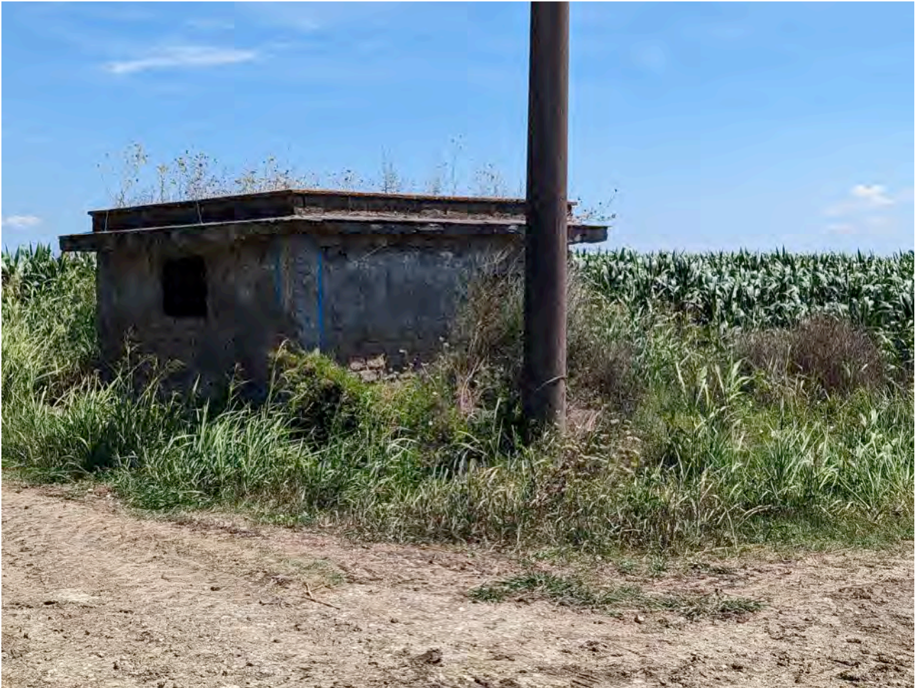
Figura 27: Struttura muraria in tufelli e cemento.
