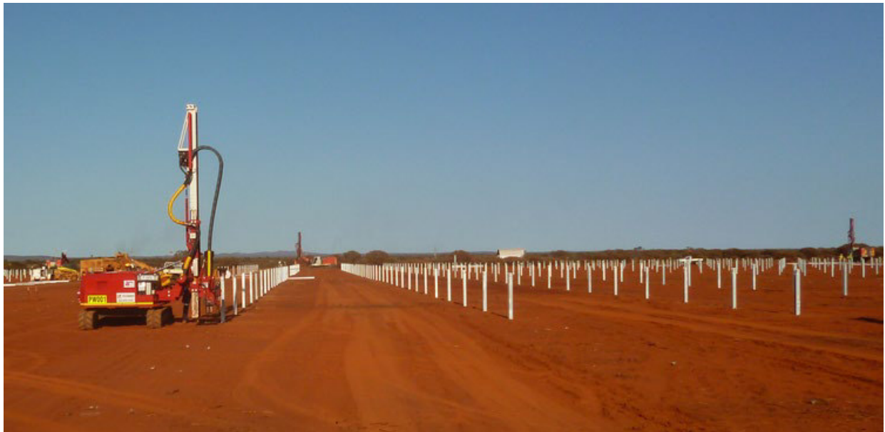
Figura 50: Infissione sostegni a mezzo di battipalo
