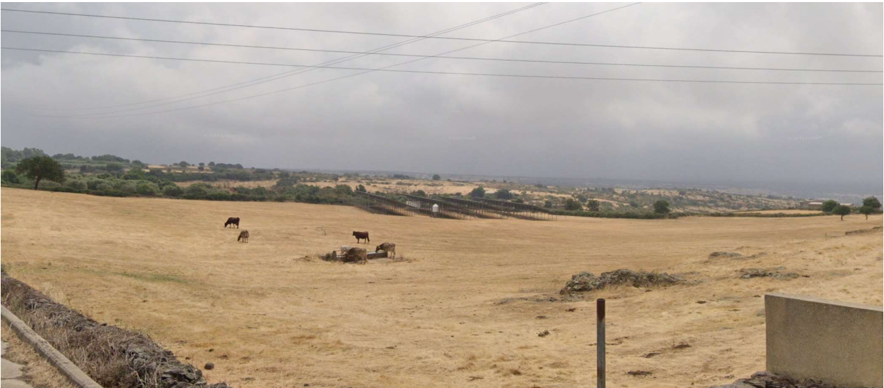
Figura 50 - Immagine dell'impianto fotovoltaico esistente.
