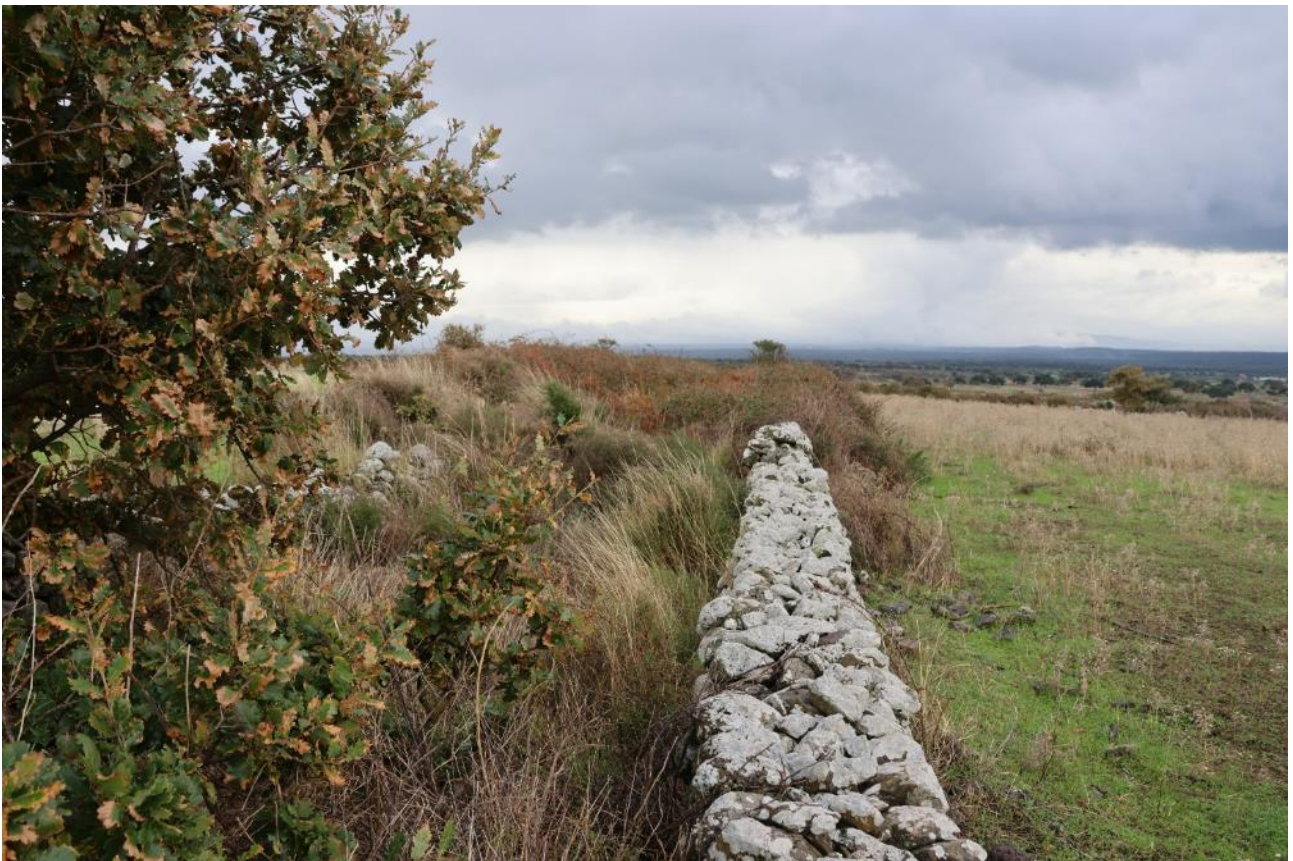
Figura 20: Doppia cortina di muri tradizionali in pietre a secco, entro la quale si sviluppata un tratto di viabilità rurale carrabile ad uso comune, oggi quasi del tutto occupata da vegetazione naturale, erbacea ed arbutiva, associata ad individui arborei di Quercus pubescens , Quercus suber , Crataegus monogyna , Olea europaea var. sylvestris . Tale discontinuità lineare divide in due settori l'area di studio (a dx settore nord-orientale, a sx settore sud-occidentale).
