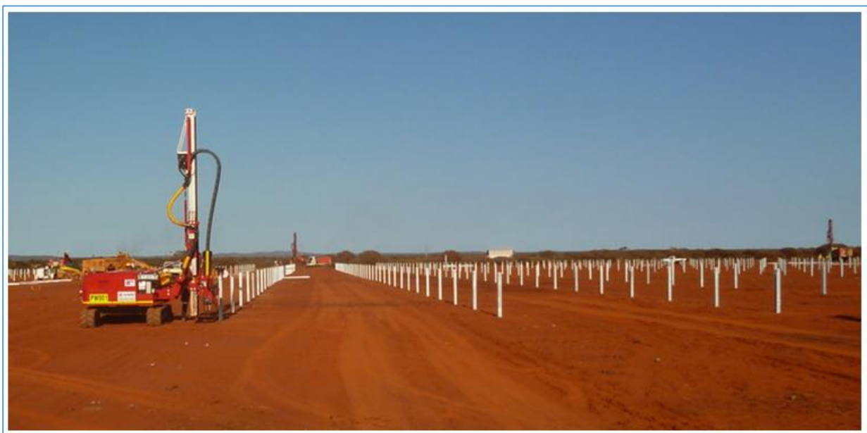
Figura 6: esempio di infissione sostegni a mezzo di battipalo, da Relazione Tecnica.
