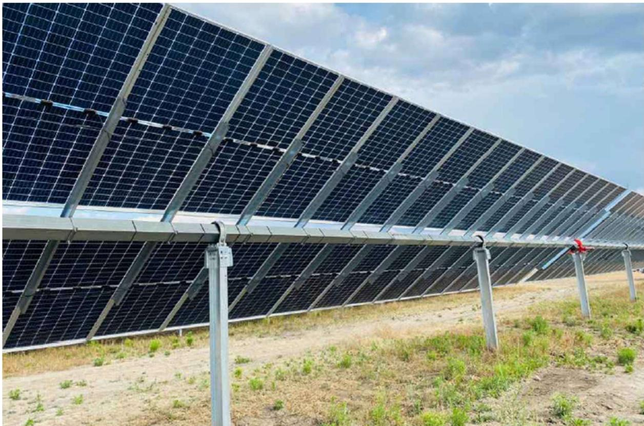
*Figura 21 - Esempio di tracker monoassiale montante moduli bifacciali: si scorge in rosso il motore per l'inseguimento solare*
