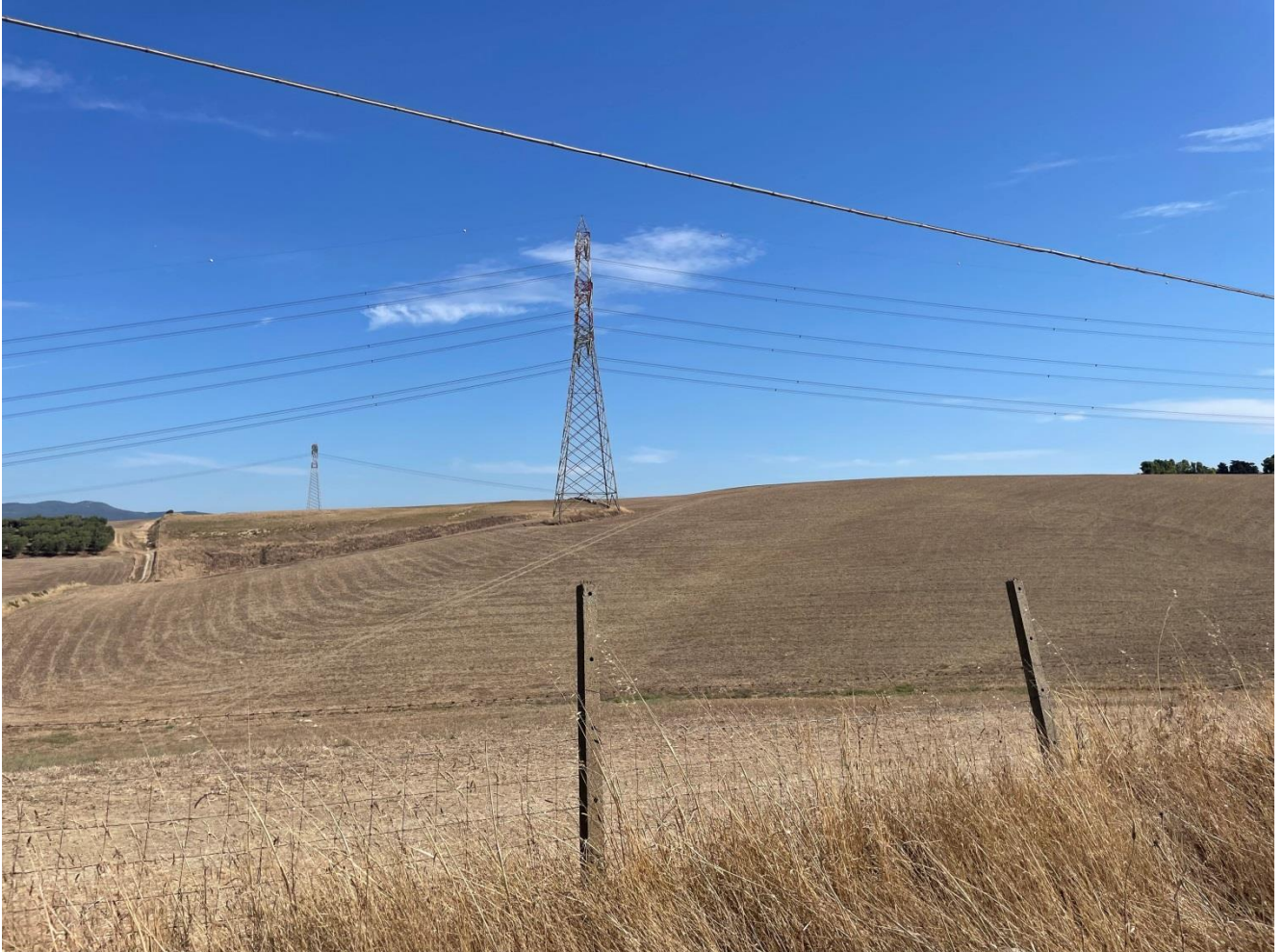
Figura 8 – PUNTO DI VISUALE 1 - STATO DI FATTO
