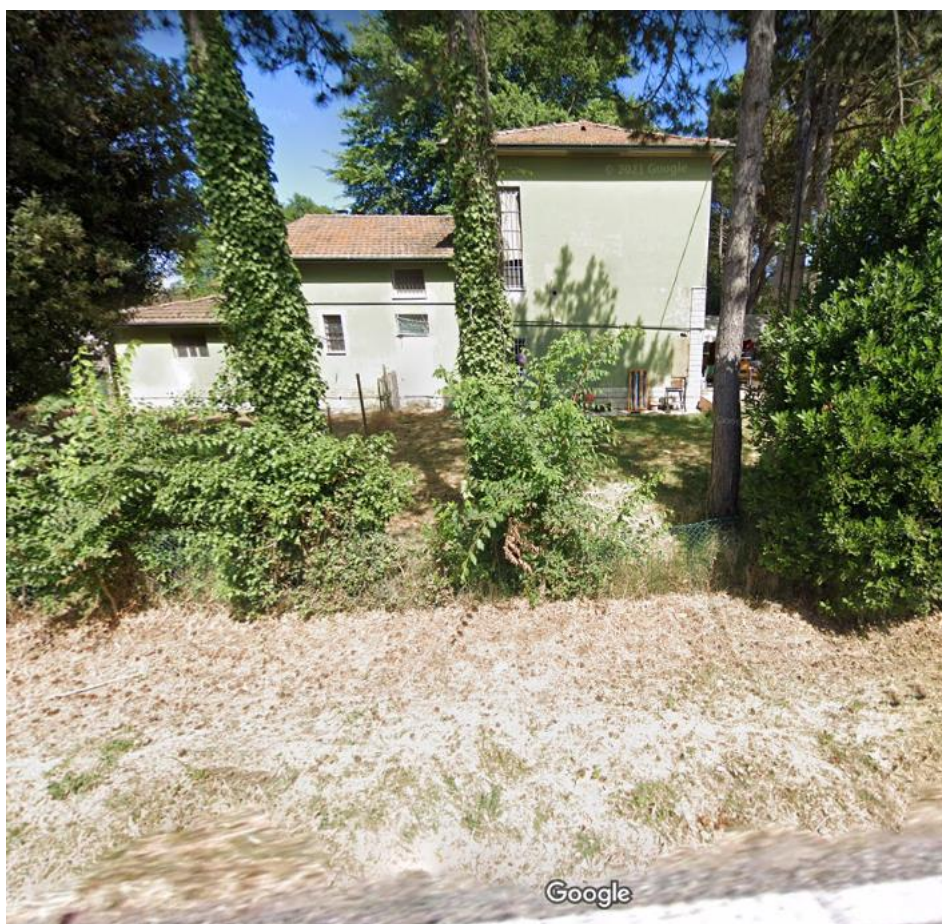
Figura 7.6: edificio abitativo (potenziale interferenza caso C)
