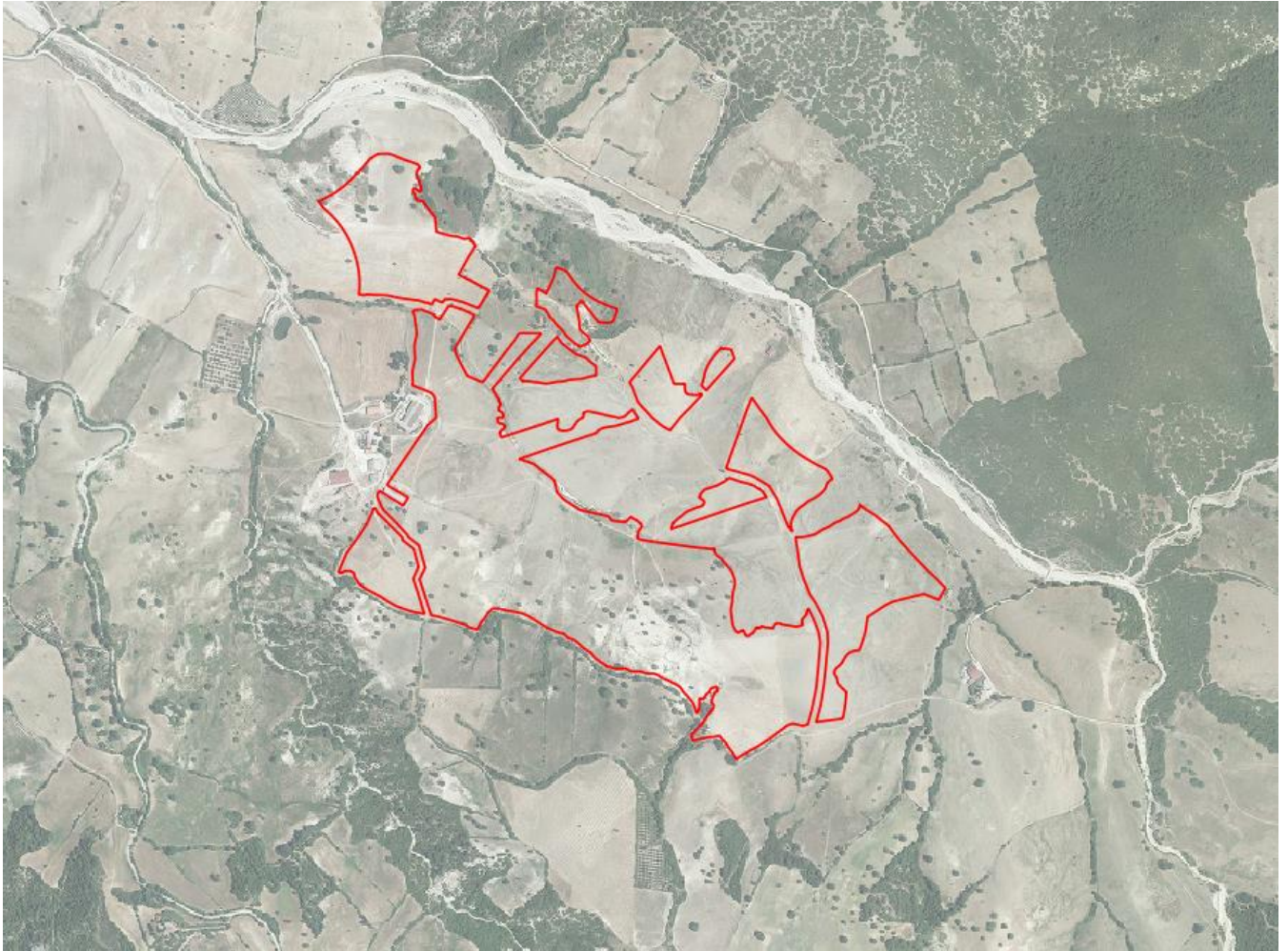
Figura 1 -Inquadramento area campo fotovoltaico su base ortofoto (l'area impianto è indicata in rosso)
