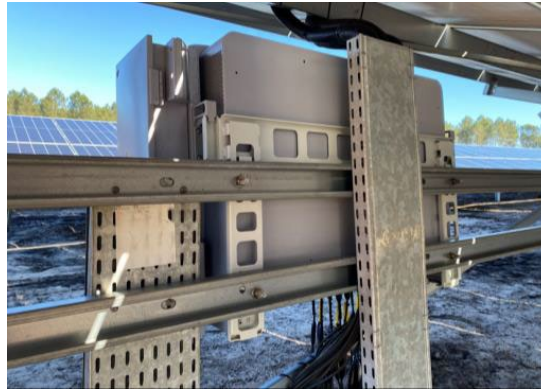
Figura 7: Supporto per quadri elettrici
