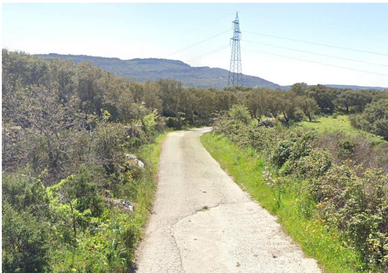
Figura 6.3 Viabilità esistente di collegamento alla S.P.12 denominata "Monte Untulzu"
