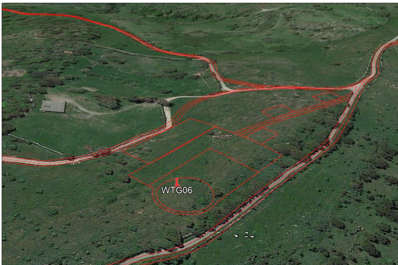
Figura 6.13 – Vista dell'asse di nuova costruzione di accesso alla postazione WTG06 (vista da nord)
