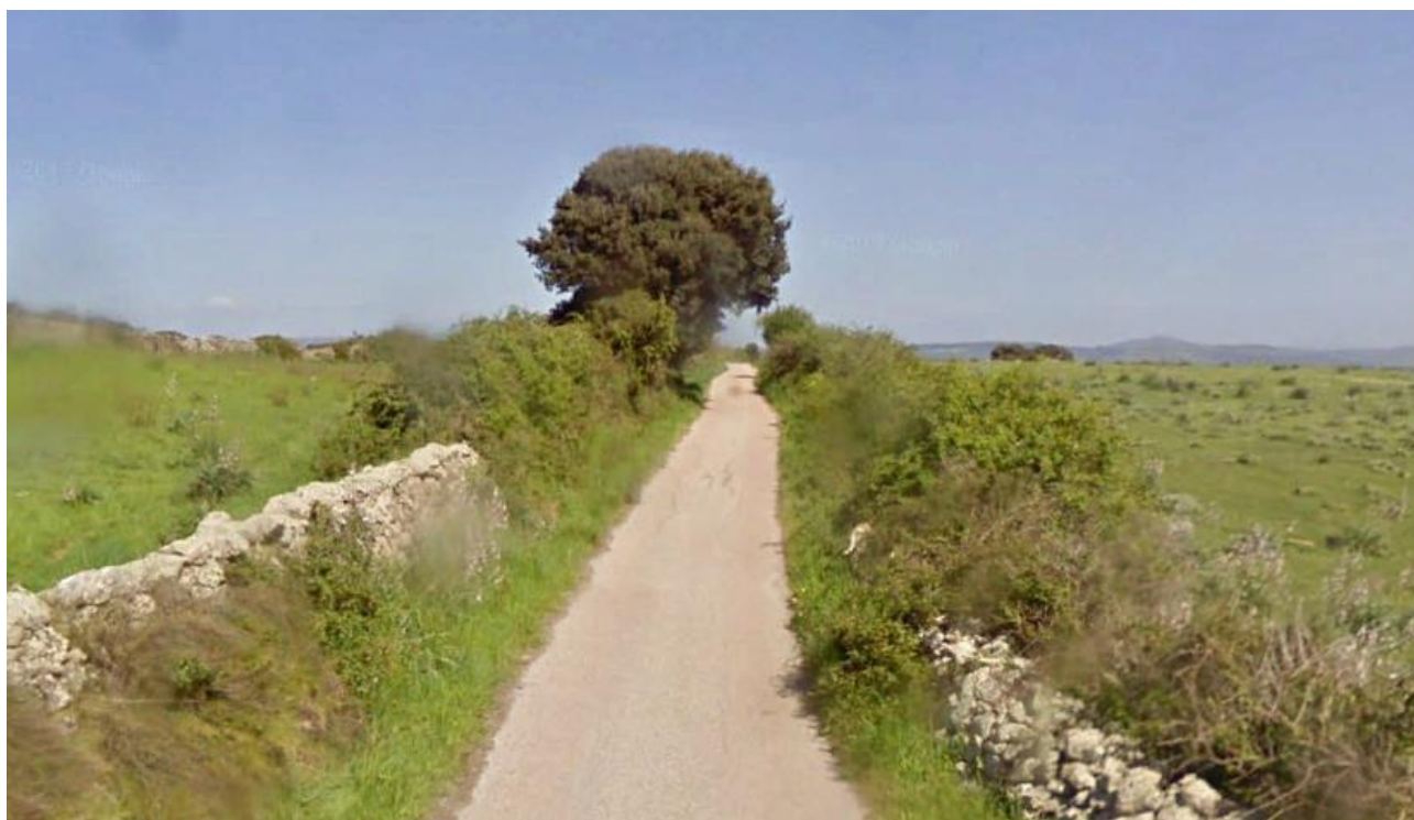
Figura 6.5 – Tracciato rurale esistente da adeguare di accesso alla postazione eolica WTG02
