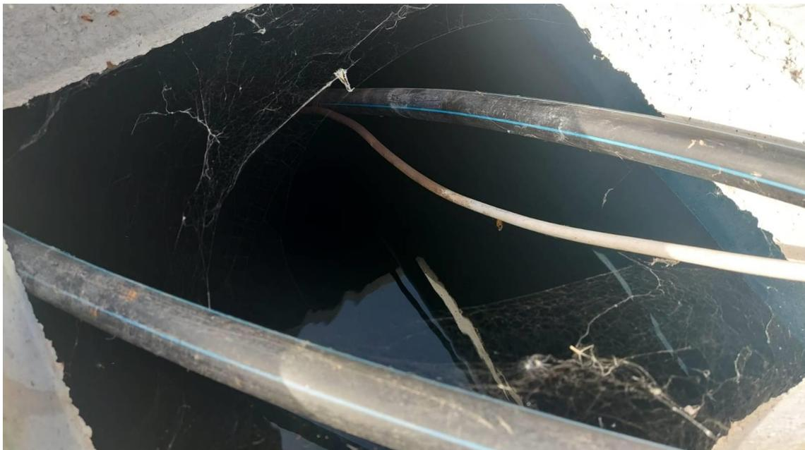
E' una piccola scaturigine che alimenta una vasca tramite un tubo in gomma di diametro di circa 2 cm immerso nel terreno alla profondità di circa 30-50 cm.
