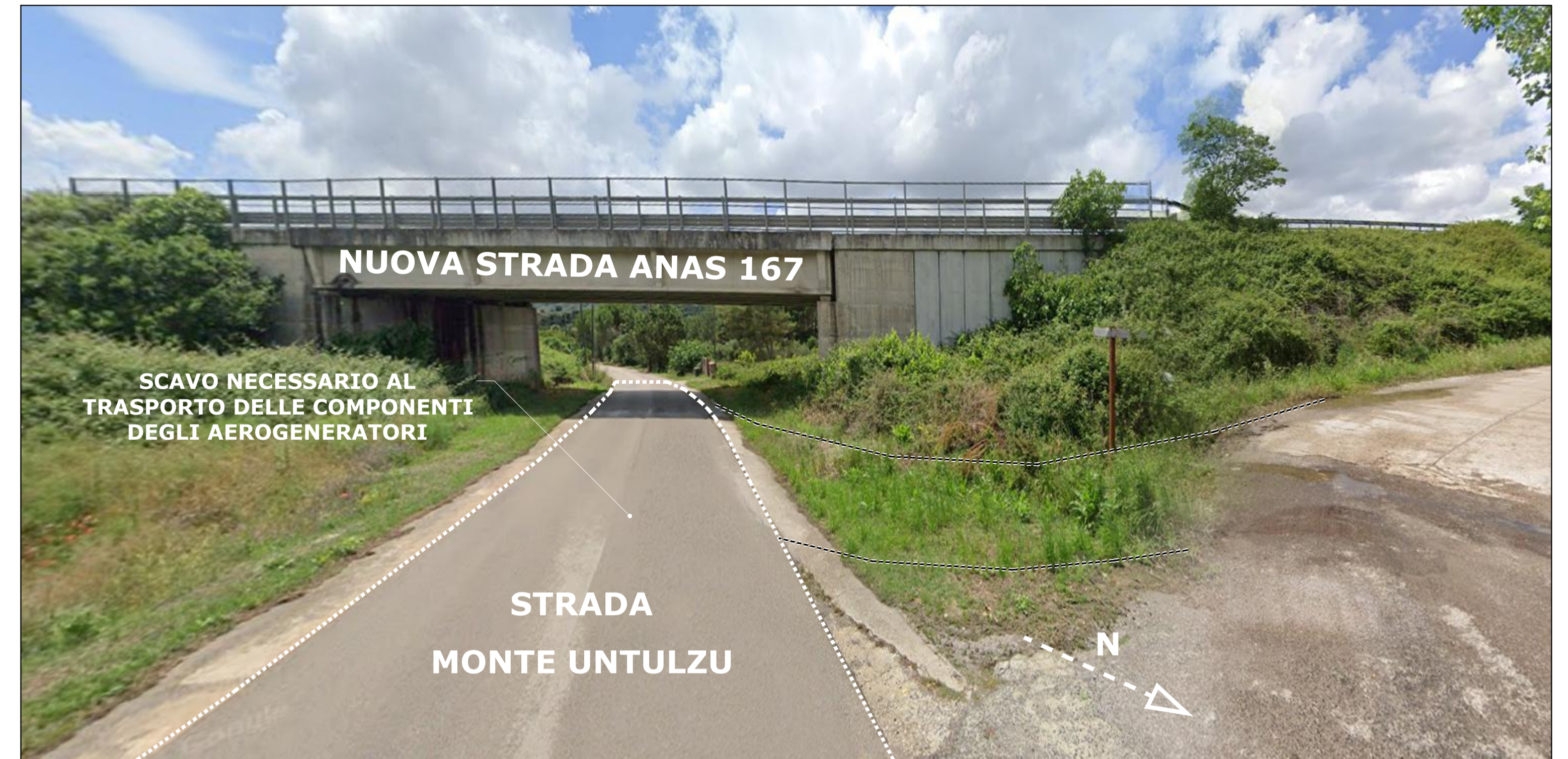
OB.18 - PUNTO 1 - VISTA DA TERRA (OVEST)
