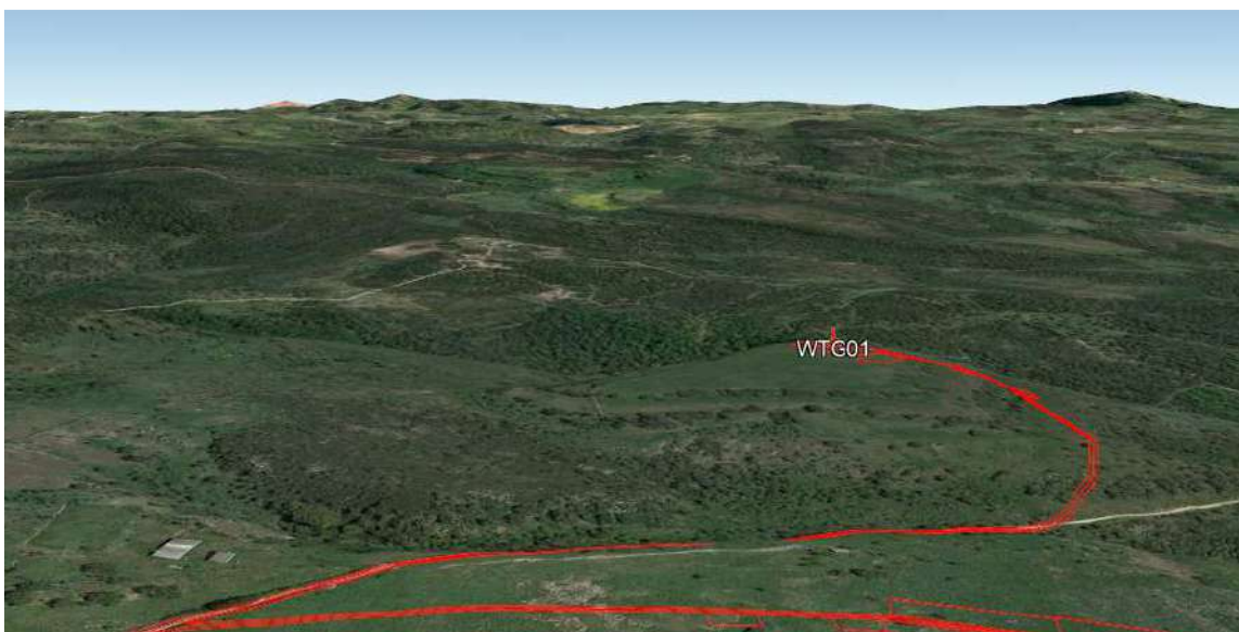
Asse di accesso alla postazione eolica WTG01 (vista da sud-ovest)
