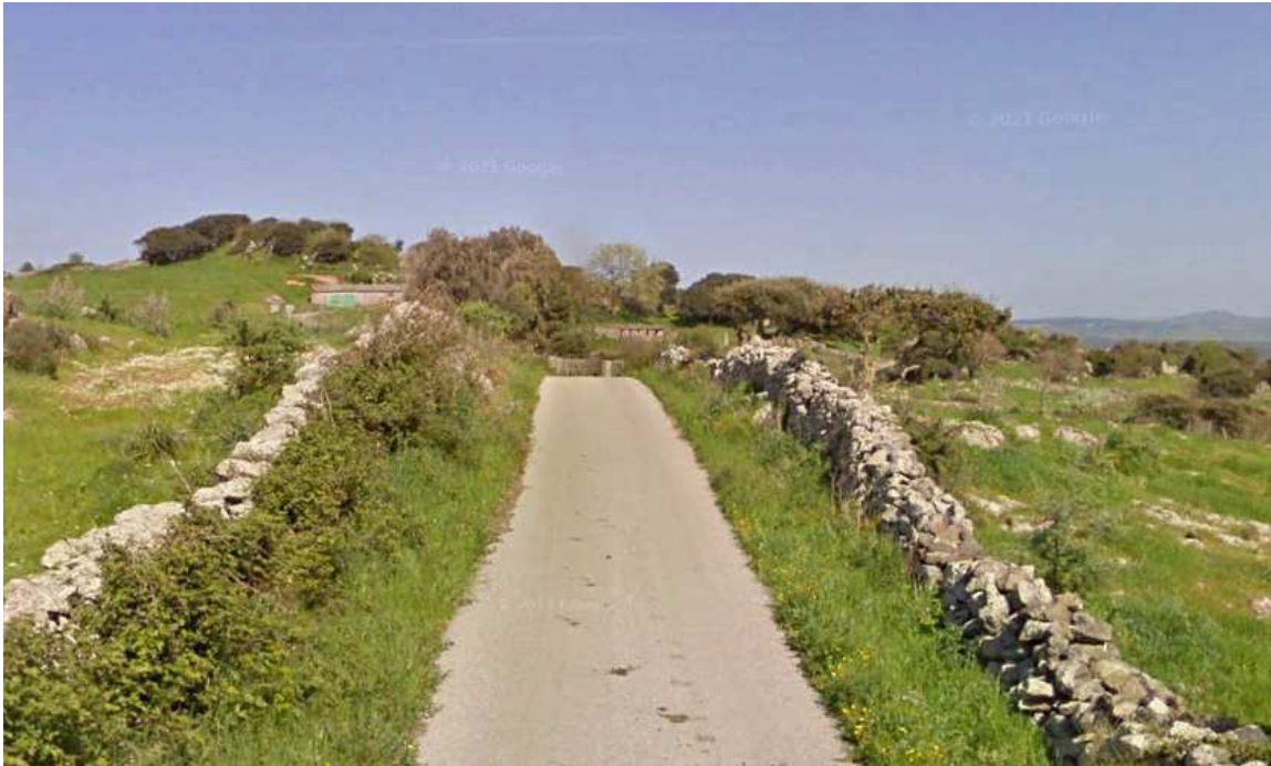
Tratturo bitumato di accesso alla postazione eolica WTG05 (direzione est)
