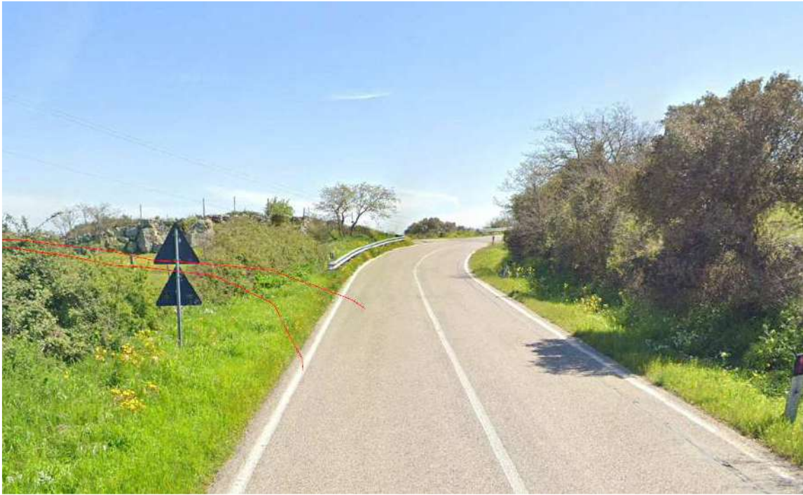
Punto di accesso previsto sulla SP 12 per accedere alle postazioni eoliche WTG02, WTG01, WTG05, WTG06 e WTG07 (direzione sud)
