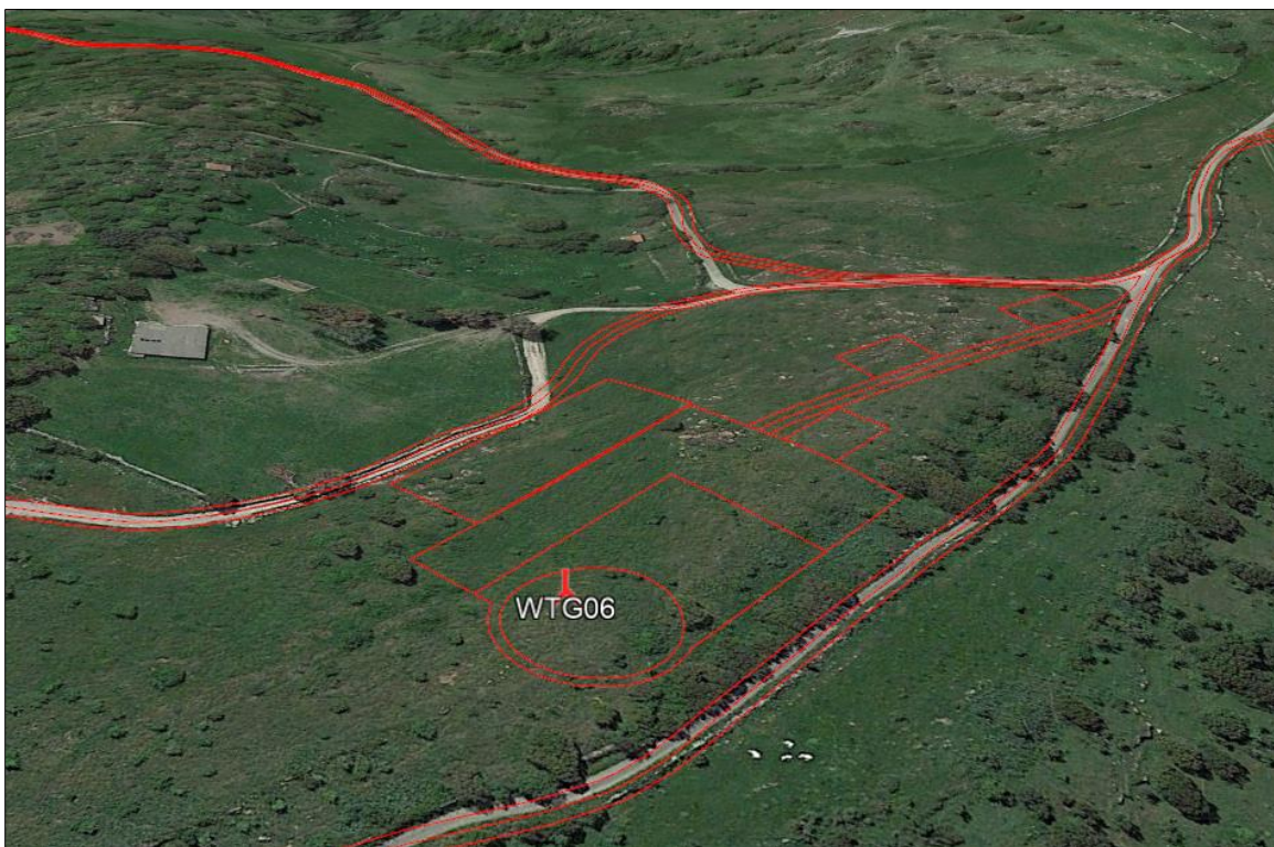
Vista dell'asse di nuova costruzione di accesso alla postazione WTG06 (vista da nord)
