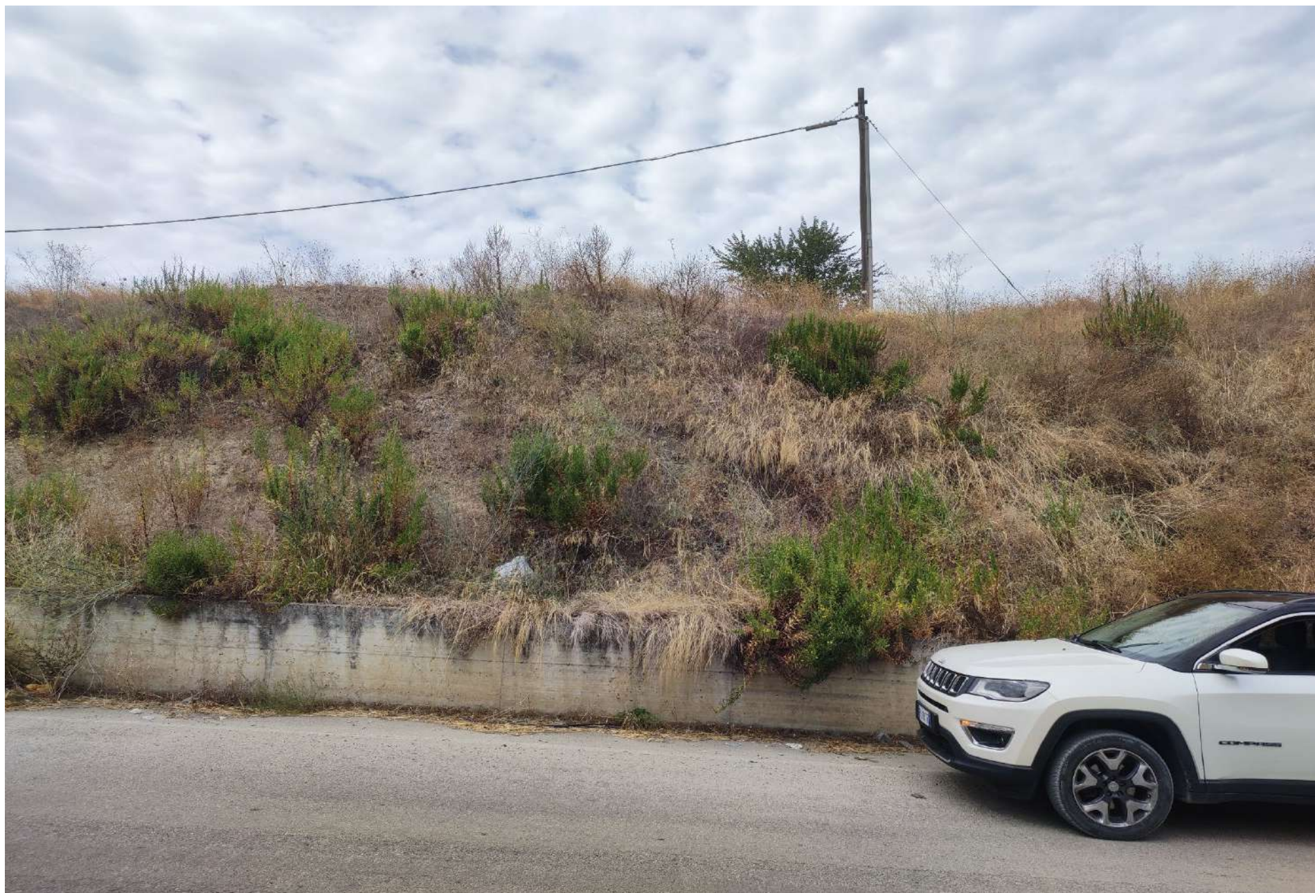
Fig. 15 Punto di presa n. 4 stato di fatto (Regio Tratturo Celano Foggia)
