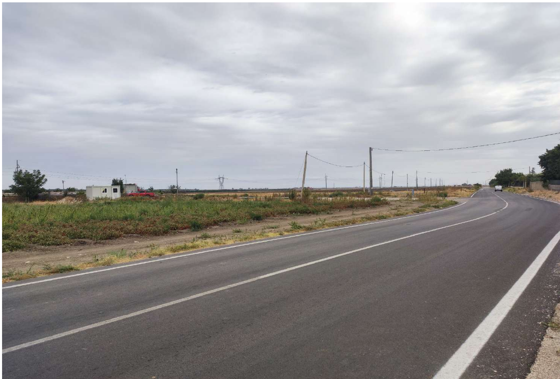
Fig. 43 Punto di presa n. 11 stato di fatto (Masseria Pavoni - San Giusto)
