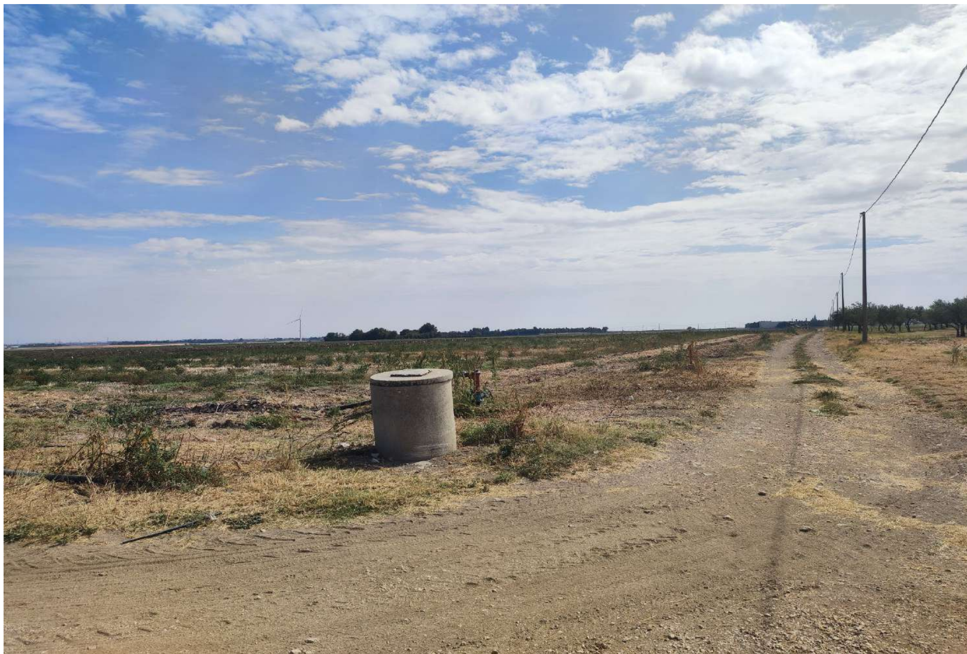
Fig. 67 Punto di presa n. 17 stato di fatto (Masseria Posta di Colle)
