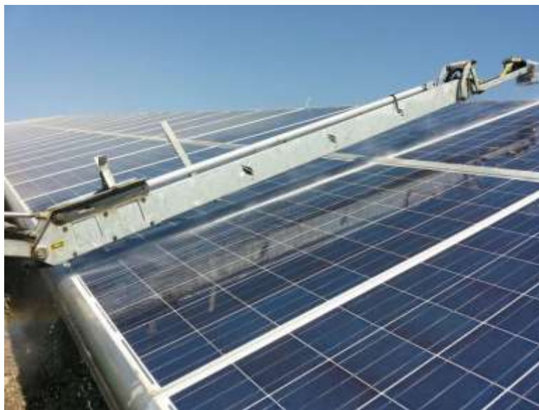
Figura 13 - Operazioni di pulizia moduli effettuate con sistema atomizzatore con uso esclusivo di acqua.
