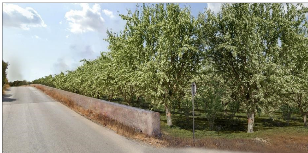
Figura 4 - Vista 1: da SP30 post operam
