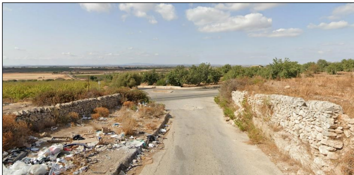
Figura 9 - Vista 4: da SR33 e SP30 ante operam
