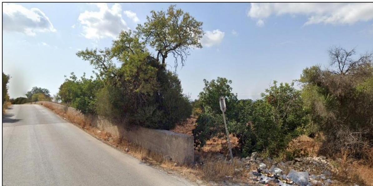
Figura 3 - Vista 1: da SP30 ante operam
