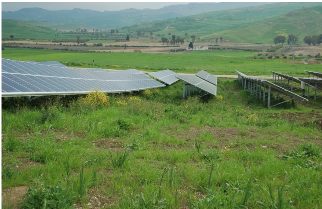
Figura 15 – Esempio di inerbimento diffuso con vegetazione spontanea post-culturale presso Parco Fotovoltaico “Villalba di Gesù” da 5 MW
