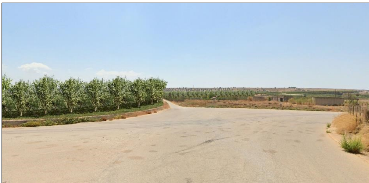
Figura 6 - Vista 2: da SR33 e SC15 post operam
