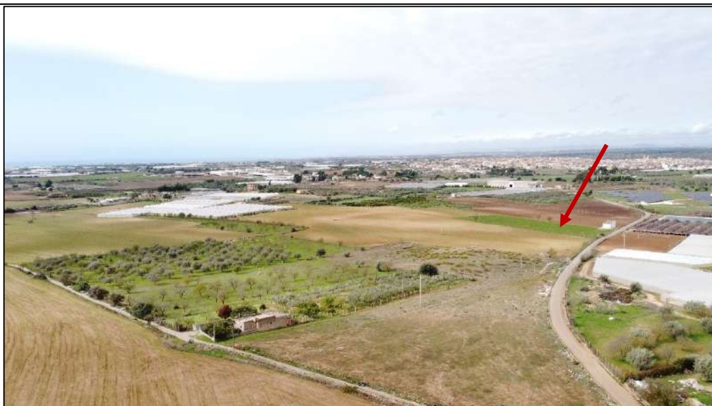
Vista da drone dell'UR 30 indicata con freccia
