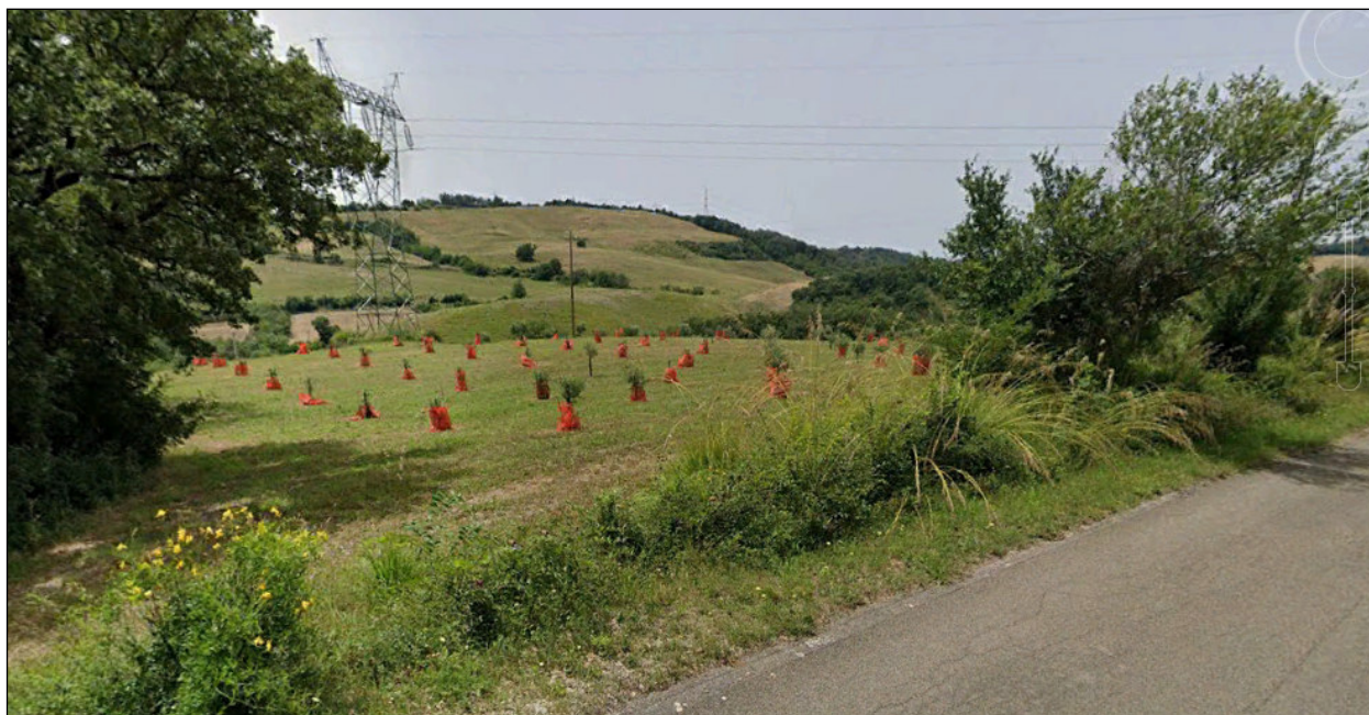
Foto 1 – Area inserimento sottostazione di elevazione – vista da E verso O
