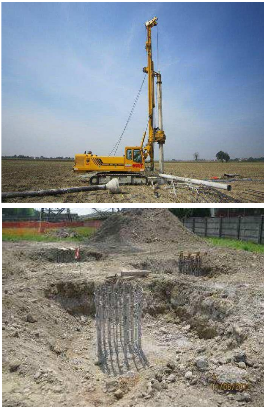
Figura 4 - Macchina operatrice per la realizzazione di pali trivellati
