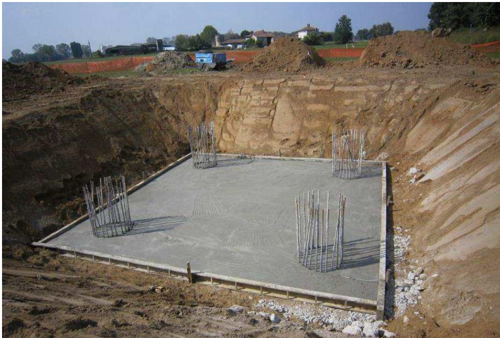
Figura 5 - Realizzazione di una fondazione su pali trivellati per un sostegno monostelo. Nell'immagine si può osservare una fondazione in fase di realizzazione. Si possono distinguere facilmente i quattro pali trivellati già realizzati e gettati (si osservano le "riprese" delle quattro gabbie metalliche) ed il piano di "magrone" sul quale impostare il monoblocco in cls
