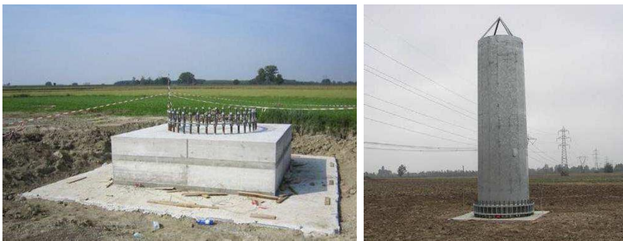
Figura 3 - Realizzazione di fondazioni superficiali tipo plinto a monoblocco per un sostegno monostelo. A sinistra si può osservare una fondazione appena realizzata, dove si può distinguere facilmente la flangia metallica dotata di tirafondi di raccordo con la parte in elevazione. A destra è riportato un esempio di fondazione completata e la sistemazione del terreno nell'area circostante
