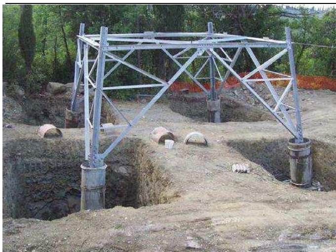
Figura 1 - Fondazioni a piedini separati
