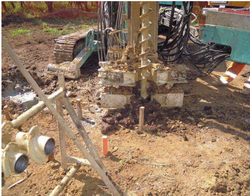
Figura 7 - Esempio di realizzazione di una fondazione su micropali tipo tubfix.
