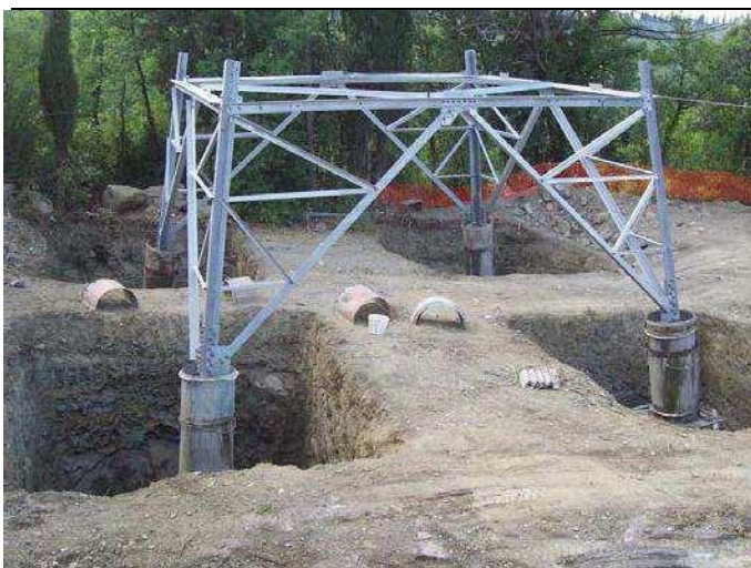
Figura 1 - Fondazioni a piedini separati
