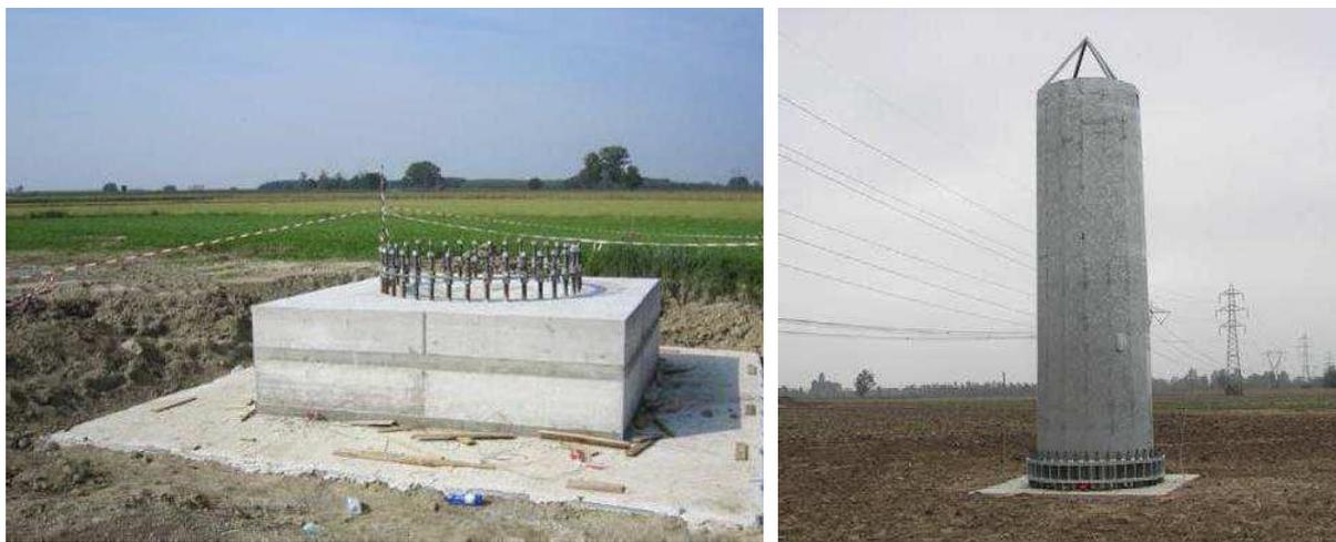
Figura 3 - Realizzazione di fondazioni superficiali tipo plinto a monoblocco per un sostegno monostelo. A sinistra si può osservare una fondazione appena realizzata, dove si può distinguere facilmente la flangia metallica dotata di tirafondi di raccordo con la parte in elevazione. A destra è riportato un esempio di fondazione completata e la sistemazione del terreno nell'area circostante
