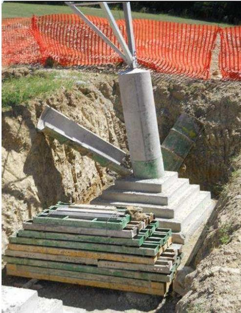
Realizzazione di fondazioni superficiali tipo CR per un sostegno a traliccio. Nell'immagine si può osservare una fondazione CR appena "scasserata". Si possono distinguere facilmente la parte inferiore a parallelepipedi tronco piramidali ed il colonnino di raccordo con la "base" del sostegno
