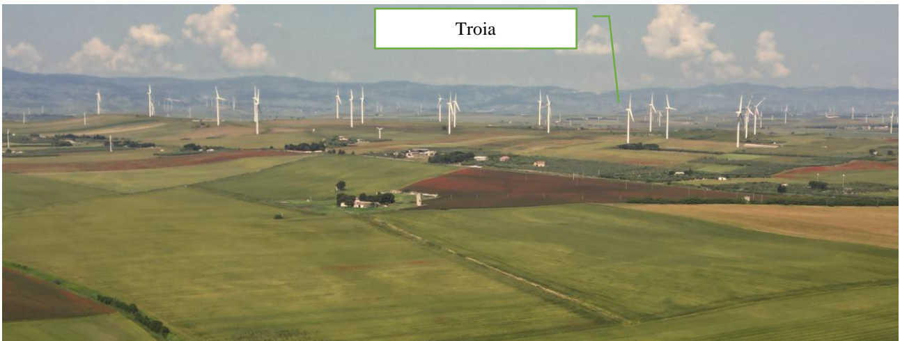
Figura 6 – Veduta eolico verso Troia
