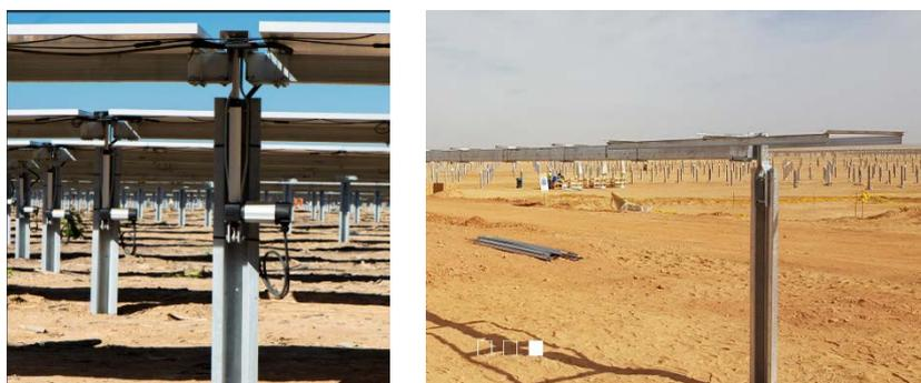
Figura 6 - Particolare strutture ad inseguimento ed attuatore
