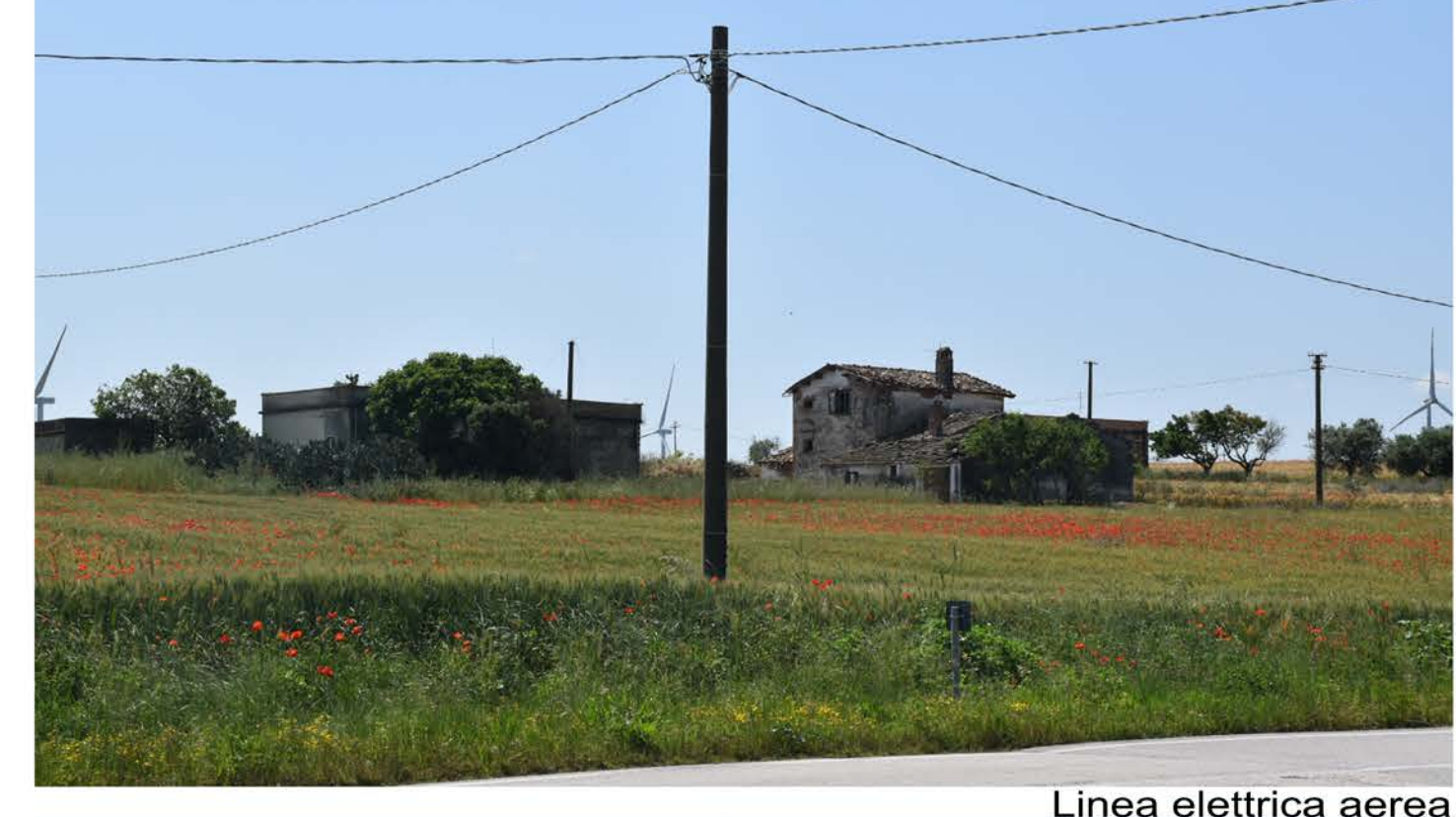
Linea elettrica aerea
