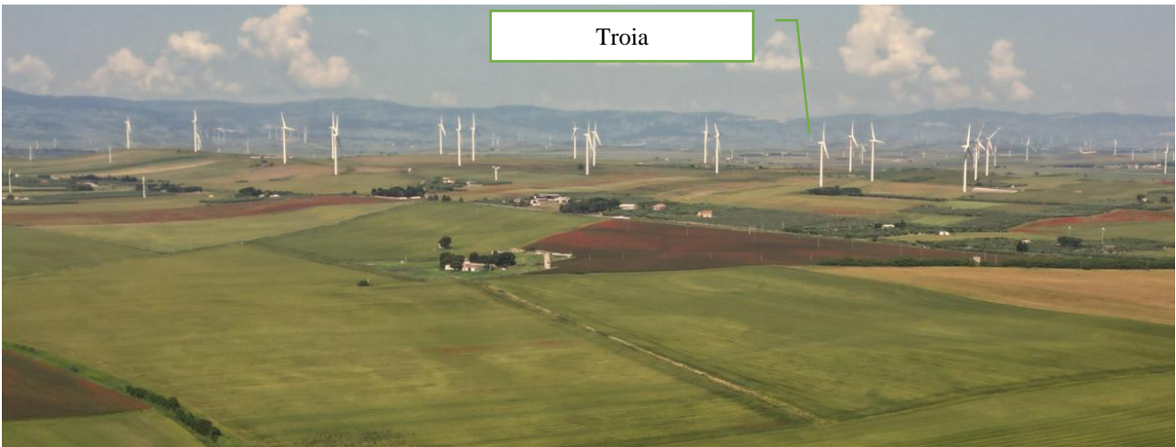
Figura 46 – Veduta eolico verso Troia
