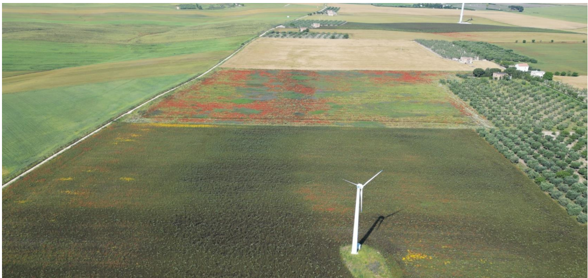
Figura 52 – Vista drone piastra P15
