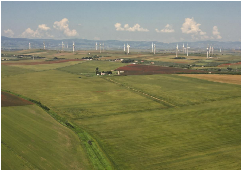
Figura 18 - Veduta eolico verso Troia
