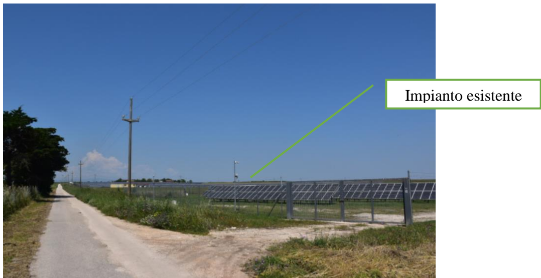
Figura 11 – Impianto fotovoltaico esistente
