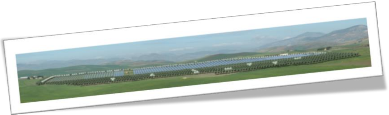
Figura 38 - Impianto fotovoltaico da 5 MW, "Heliospower", Monreale (PA) 2010
