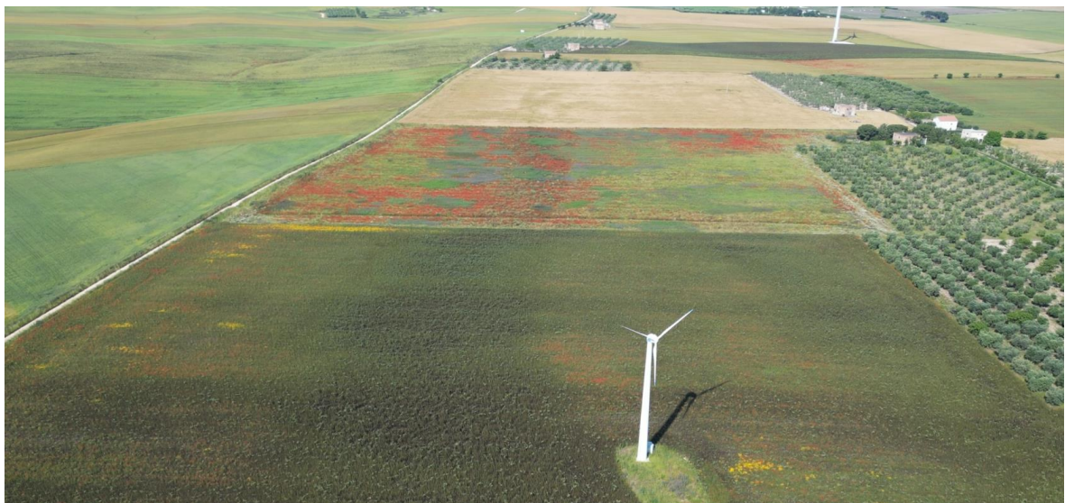
Figura 21 – Vista drone piastra P15
