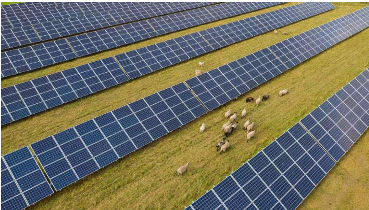
Figura 14: esempio di impianto agrivoltaico
