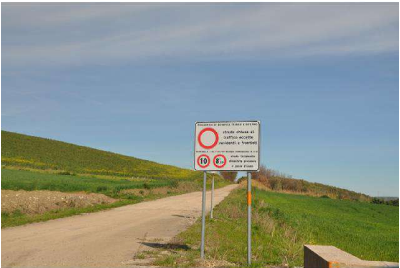
Strada del Consorzio di Bonifica Trigno e Biferno chiusa al traffico – Cono A (verso la strada chiusa)
