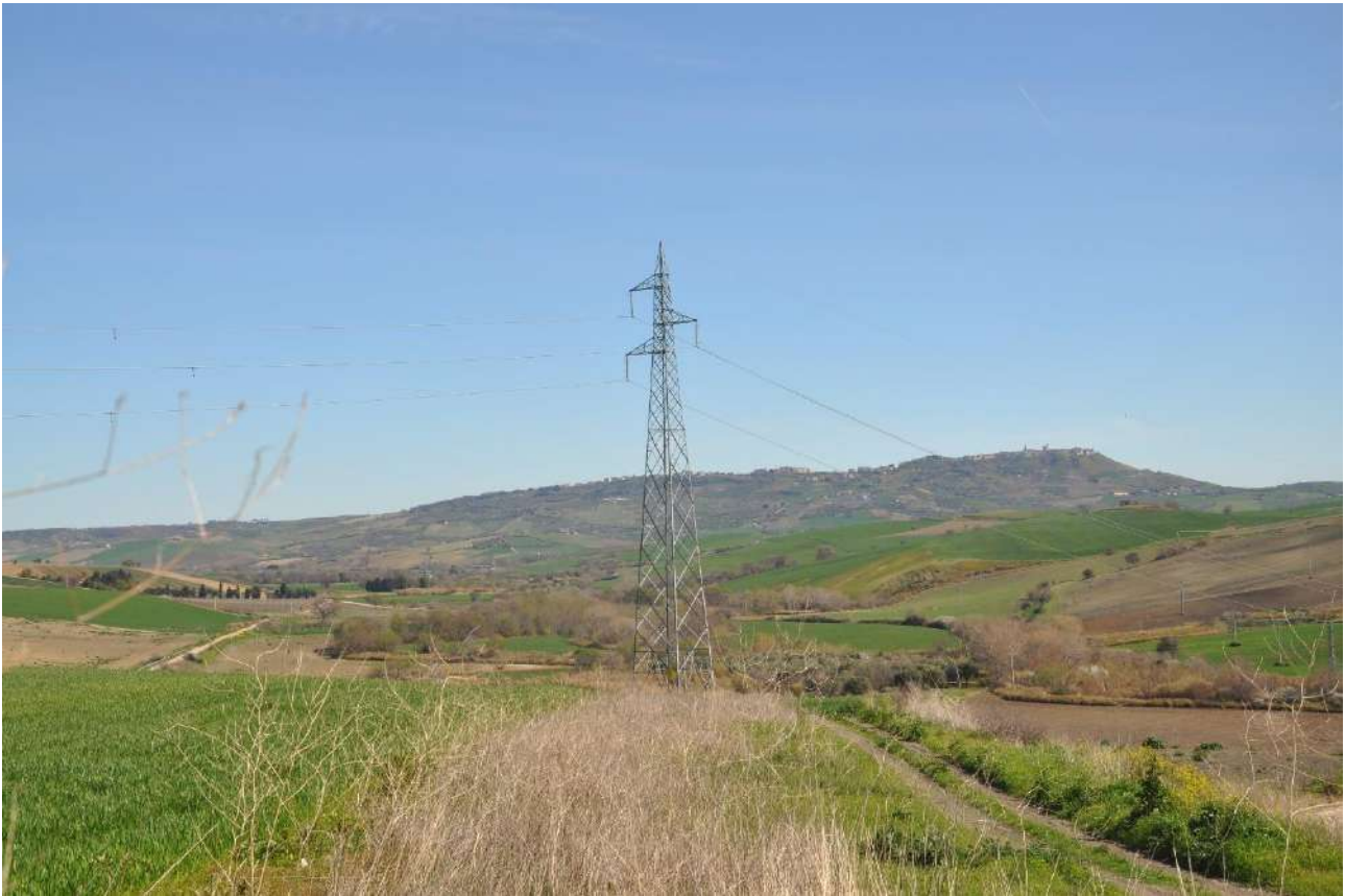
Figura 22: Traliccio della linea elettrica ad alta tensione di Terna che attraversa il sito
