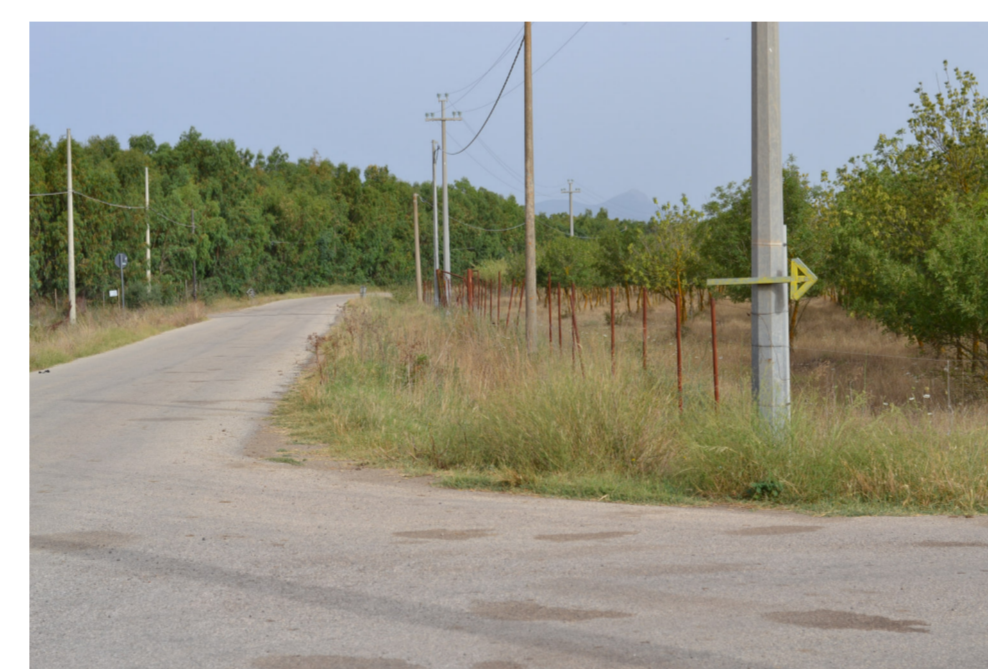
Foto 9 - Incrocio stradale alla progressiva 1.311 m.
