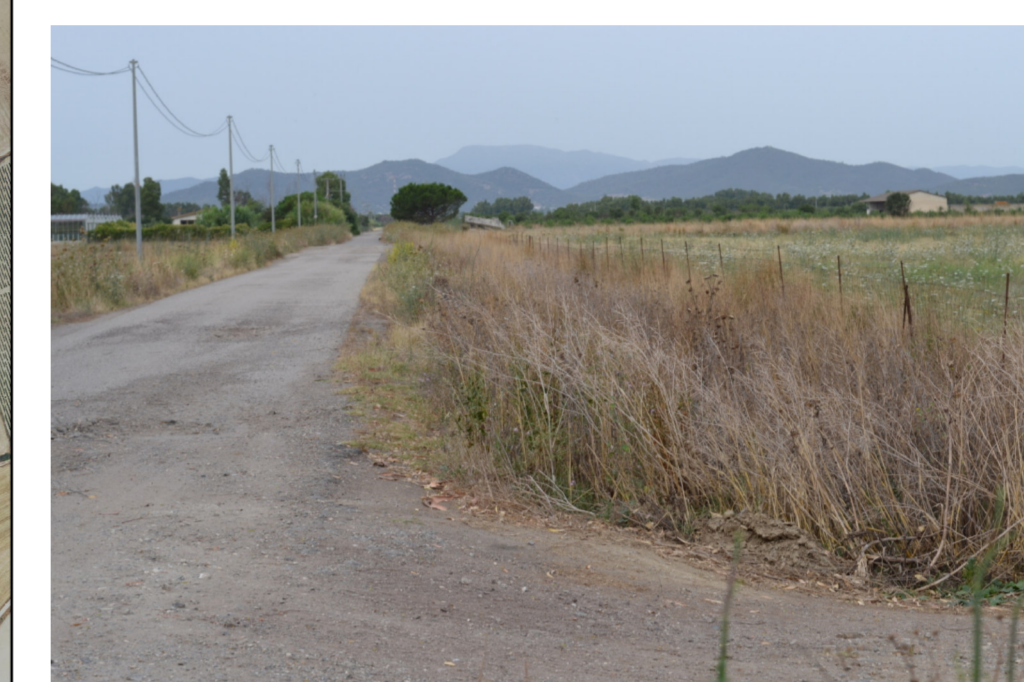
Foto 3 - Strada dx alla progressiva 257 m.
