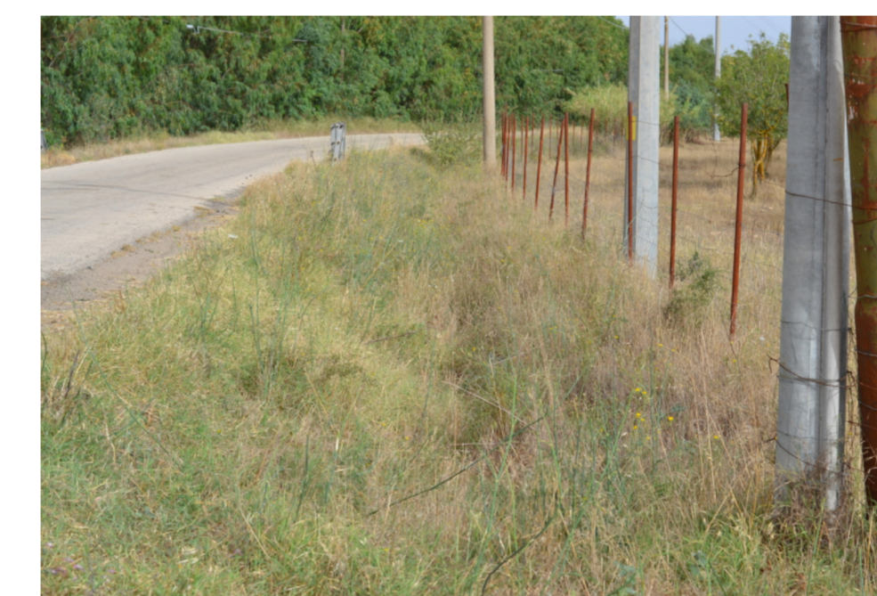
Foto 10 - Accesso dx alla progressiva 1.392 m.
