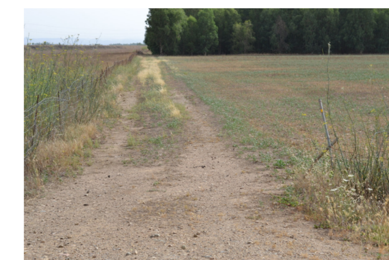
Foto 14 - Canale alla progressiva 2.461 m.
