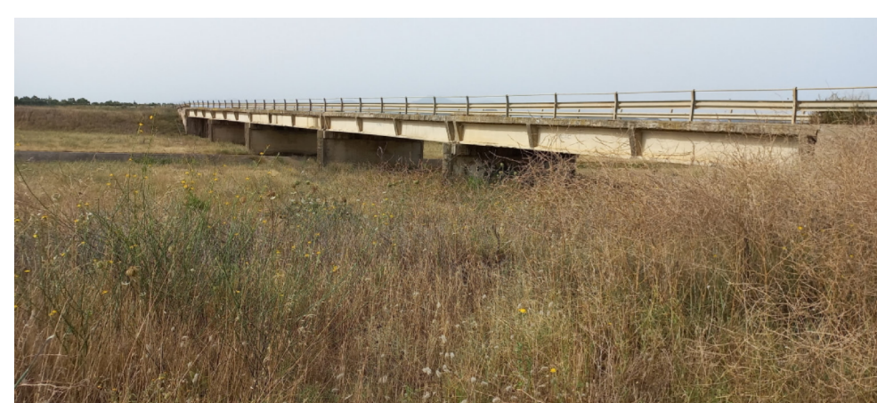
Foto 15a - Ponte alla progressiva 2.754 m.
