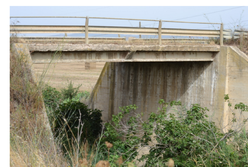
Foto 15b - Ponticello alla progressiva 2.860 m.
