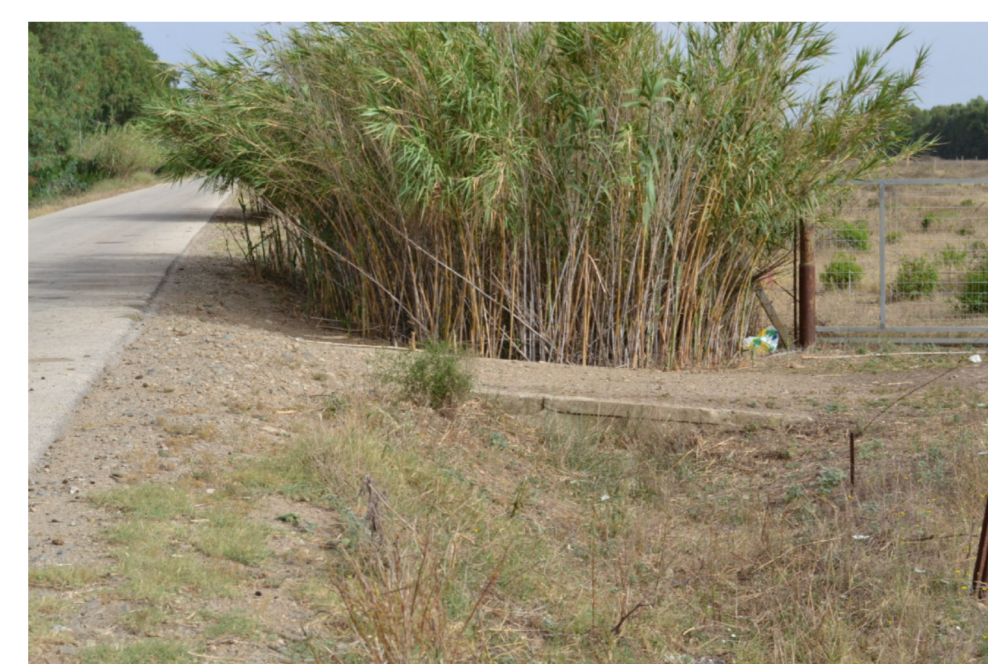
Foto 12 - Accesso dx alla progressiva 1.857 m.
