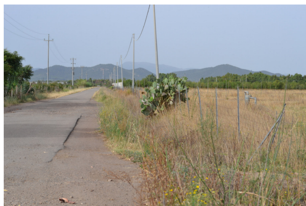
Foto 7 - Accesso dx alla progressiva 1.051 m.
