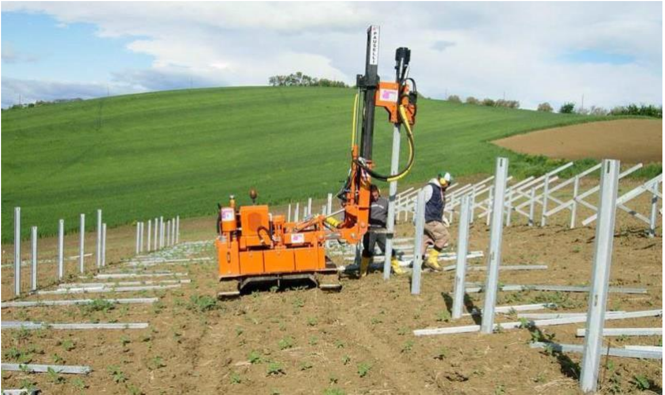
Figura 10 - Macchina battipali per l'ancoraggio delle strutture di supporto dei Tracker
