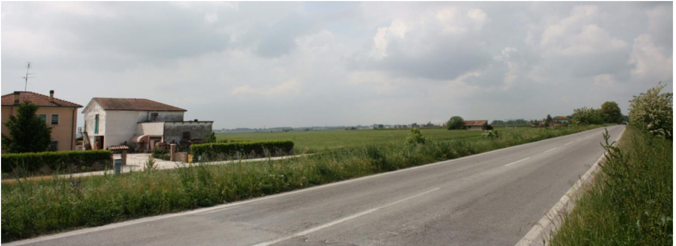
Figura 31 - Visuale da nord verso sud (dettaglio strada Maria Margotti)
