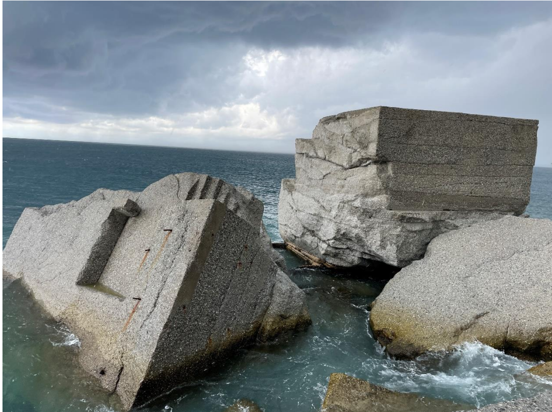
Figura 28 – Cassone e muro paraonde della testata del molo di sopraflutto danneggiati
