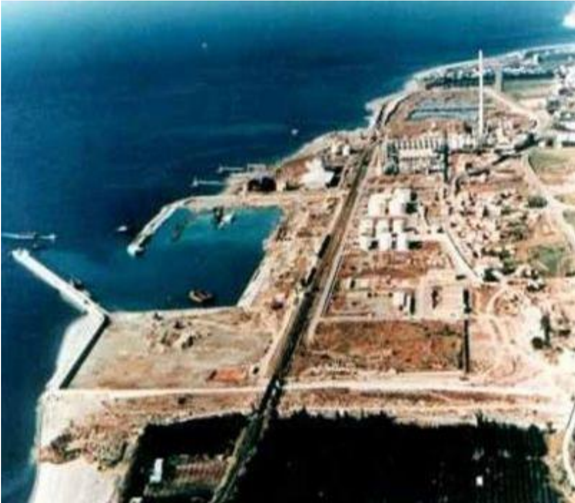
Figura 2 – Il Porto di Saline durante la costruzione
