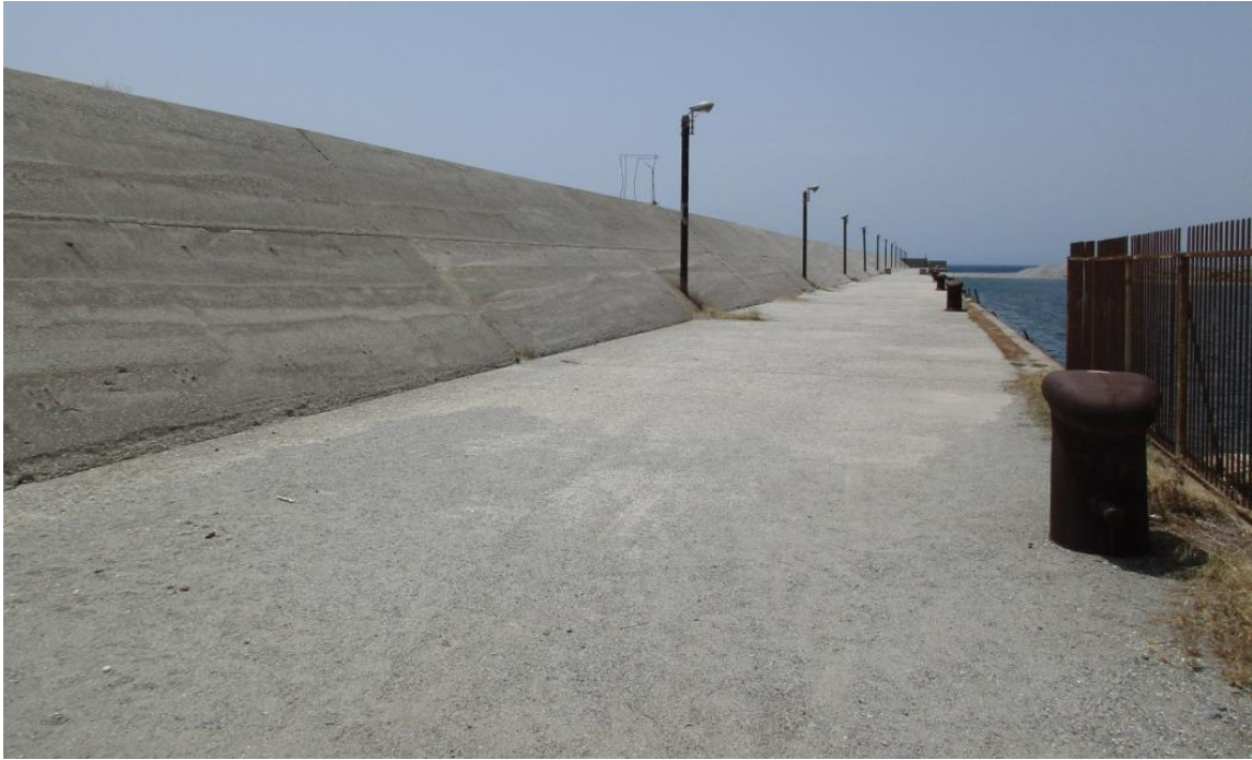
Figura 36 – molo di sopraflutto e muro paraonde
