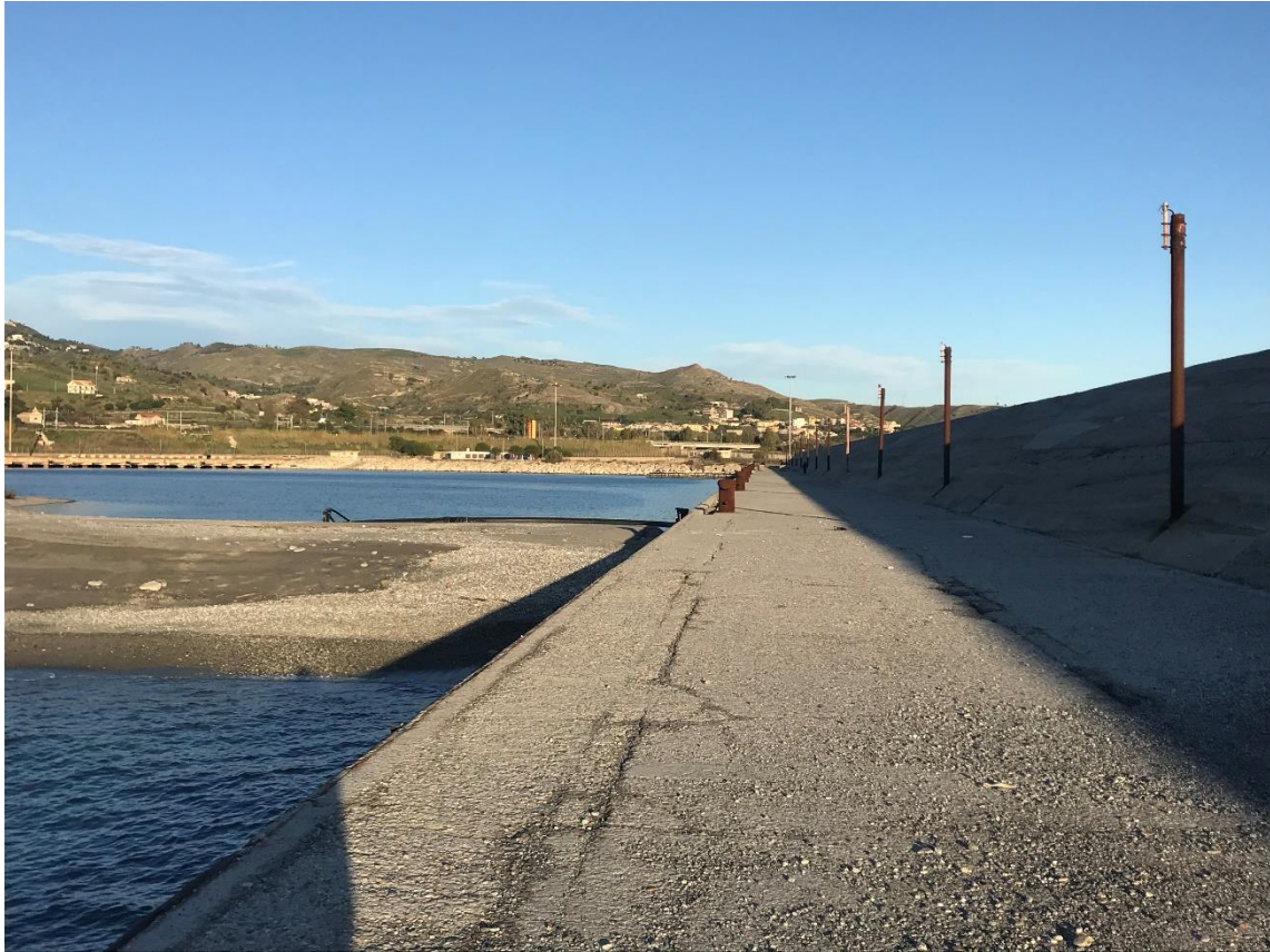
Figura 32 – Vista del porto dalla testata del molo di sopraflutto
