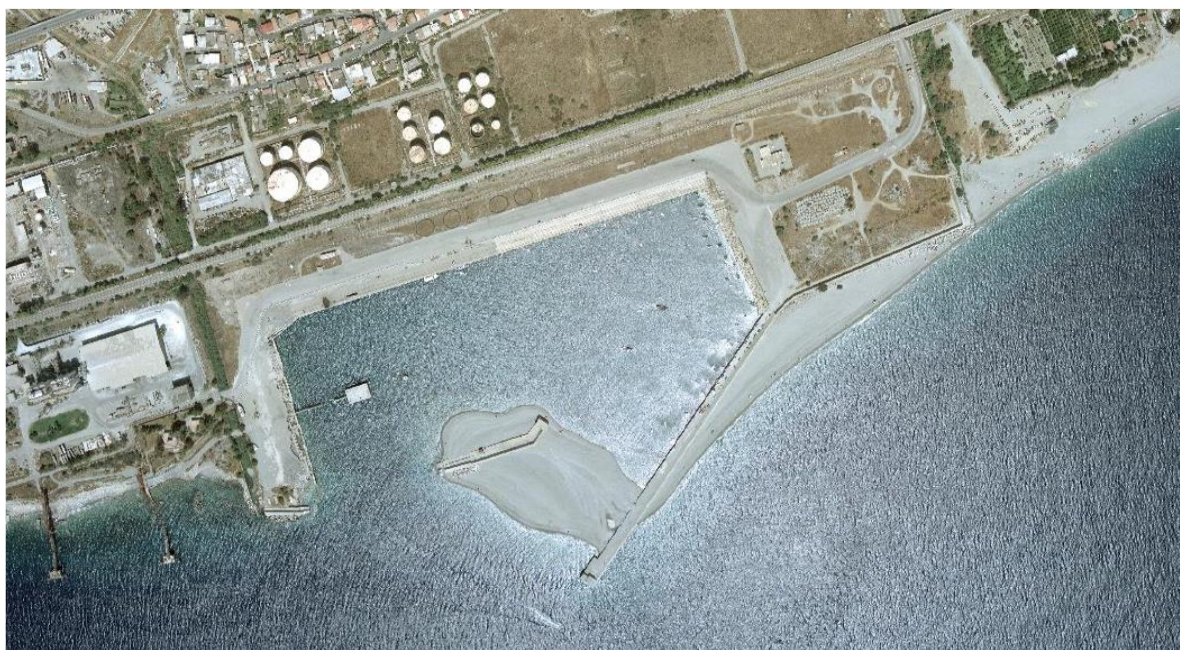
Figura 5 – Il Porto di Saline Joniche nel 2006 danneggiato dopo la mareggiata di dicembre 2003
