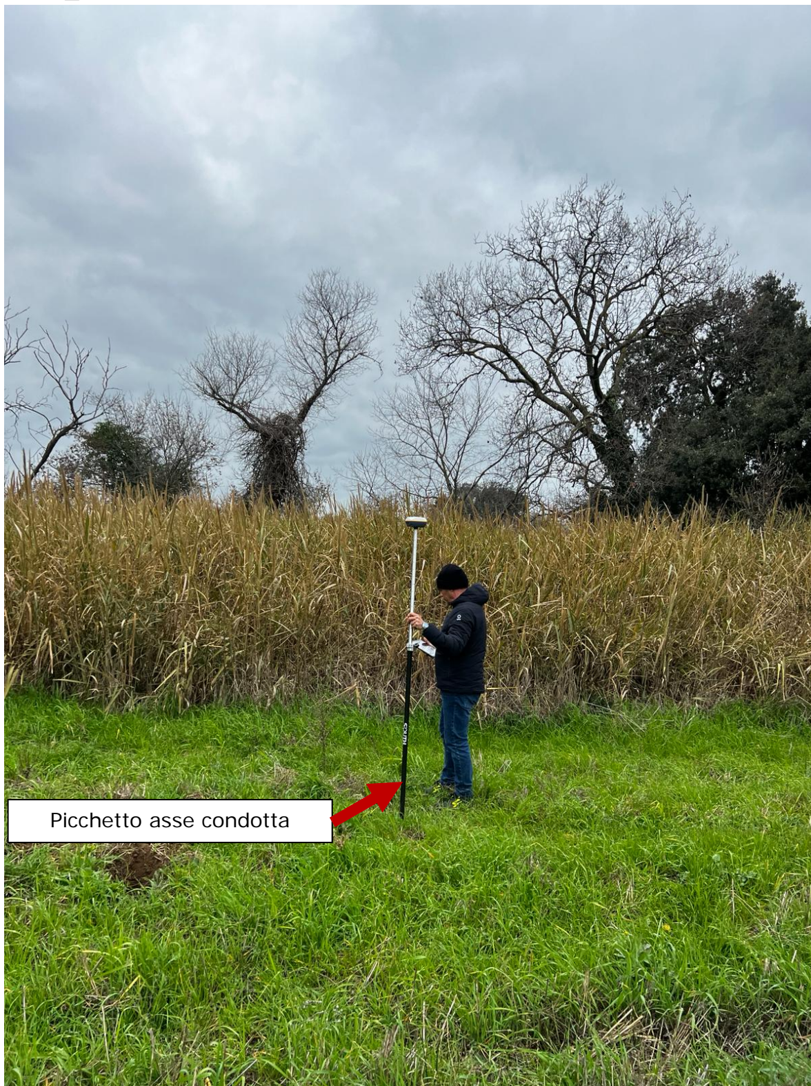
Figura 16: Foto a valle del fosso 2 in asse alla condotta di progetto
