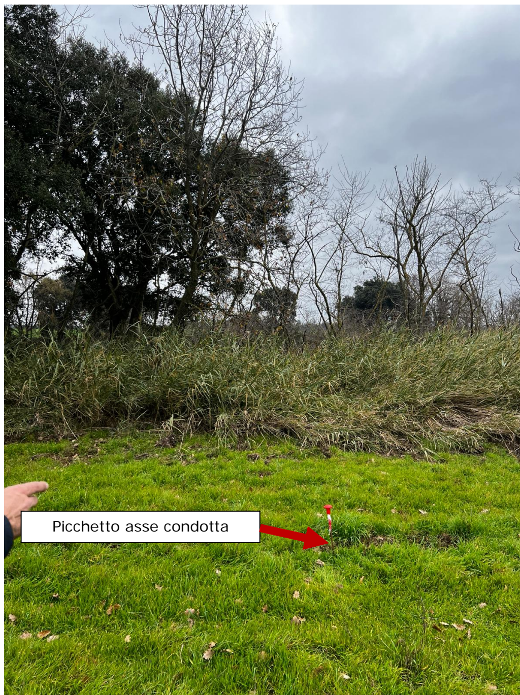
Figura 11: Foto con picchetto asse condotta
