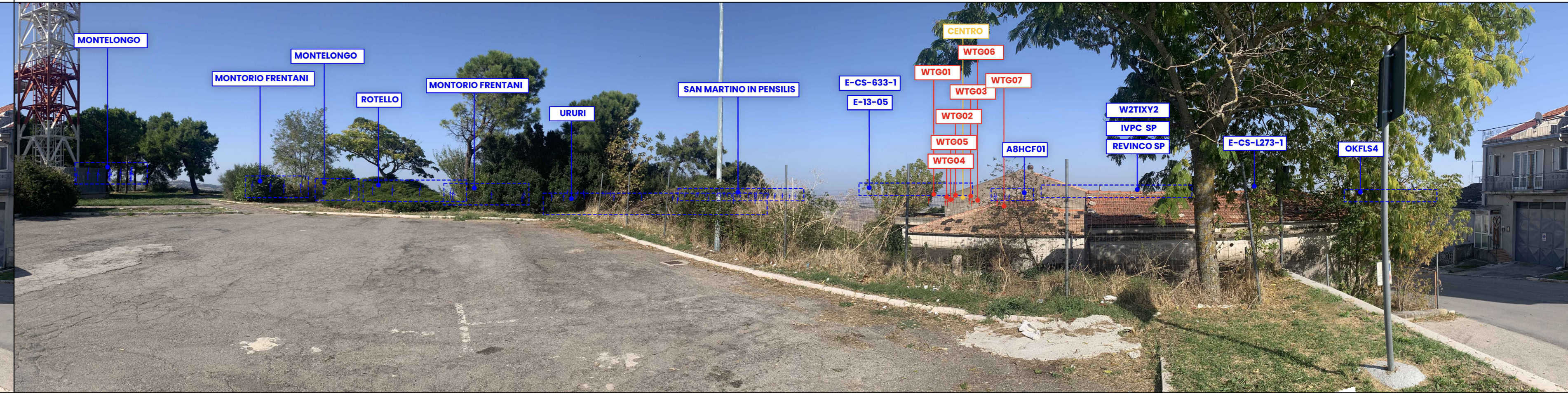
PV 12 da "SANTA CROCE DI MAGLIANO - Via della Fiera: strada di accesso al centro abitato - Centro Abitato" (B) INDICAZIONI IMPIANTI
