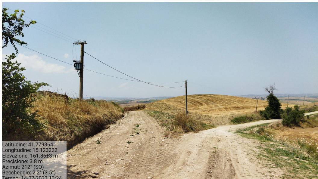
Figura 45 - Punto di congiunzione delle linee aeree MT e BT - Punto di scatto 88
