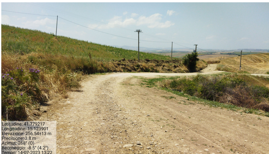
Figura 44 - Viabilità esistente da adeguare e interferenza con linea MT e BT - Punto di scatto 85
