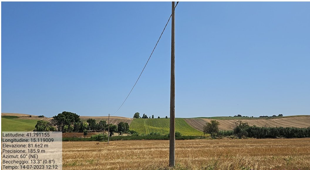
Figura 26 - Interferenza Linea BT nei pressi dell'area sitecamp
