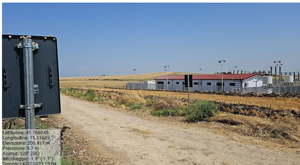
Figura 70 - Vista Stazione Elettrica a ridosso della viabilità di impianto
